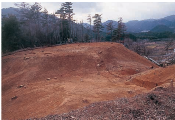
①掘割部分（東北東から）
