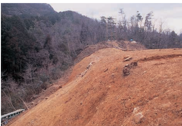
⑥平坦面と斜面部の変換線（西から）
