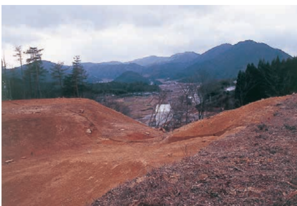
⑧掘割部分（南東から）
