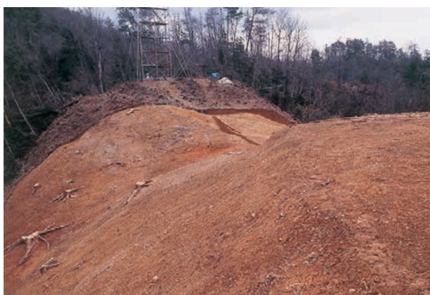
⑦掘割部分（西から）
