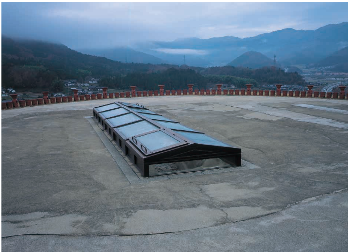
整備終了後の第1主体部（東から）
