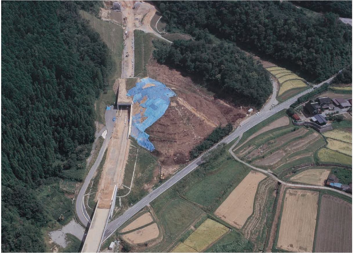
樹木伐採後の墳丘（西から・平成17年9月撮影）
