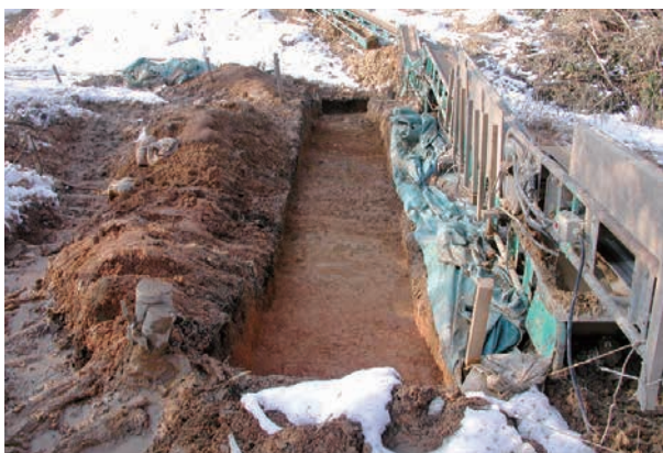
⑦ T-C全景（南東から）
