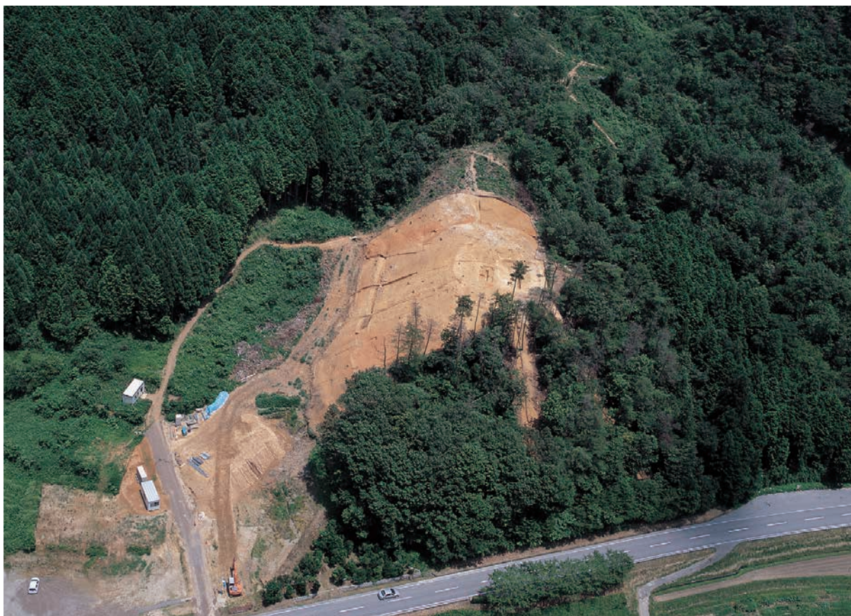
第2次本調査後の墳丘（南西から）
