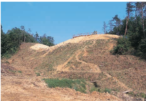
⑥第2次本調査前の北側斜面（西北西から）
