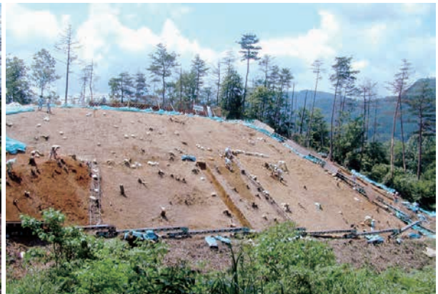
④北側斜面調査状況（北から）
