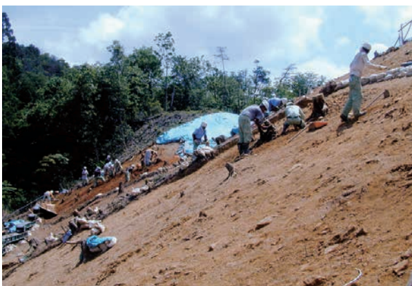
⑧北側斜面調査状況（西から）
