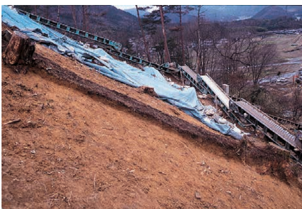
⑥墳丘北斜面中央部下半埋土断面（東北東から）
