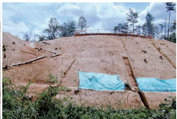
⑧道路用開削部境界線（北北西から）
