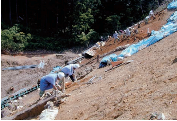
①北側斜面調査状況（西南西から）
