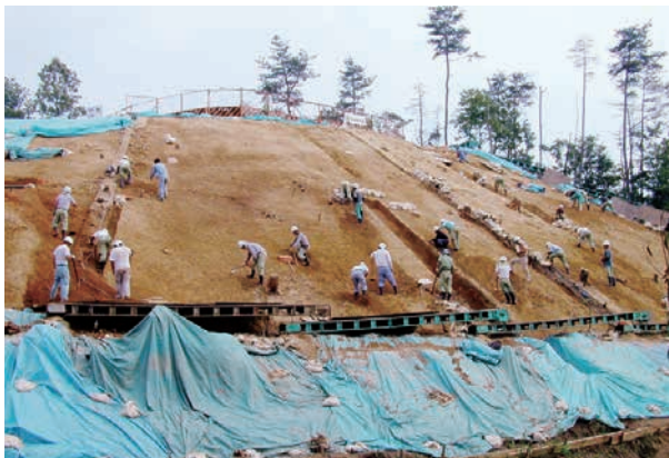
⑤北側斜面調査状況（東北東から）
