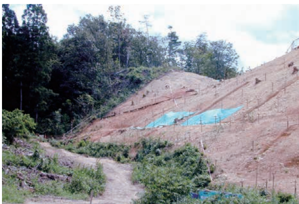
⑦道路用開削部境界線（西から）
