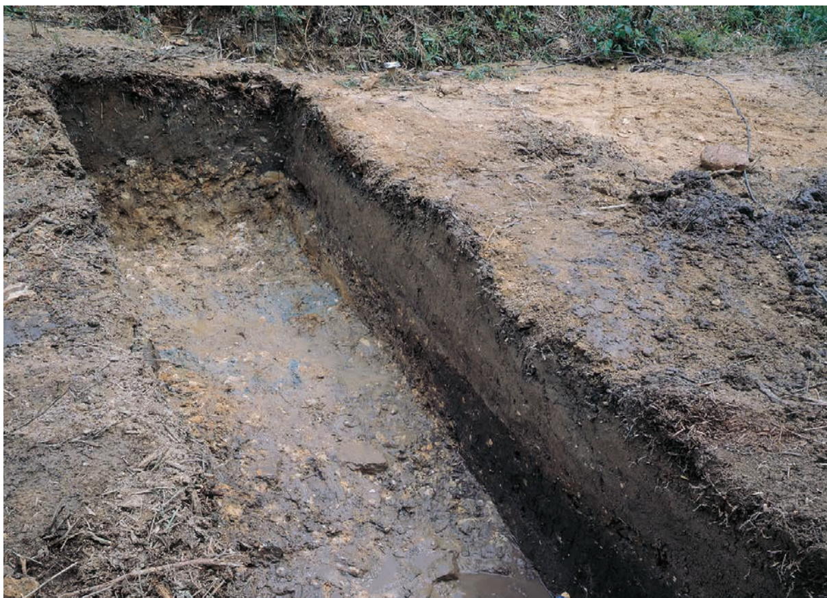
T-B 南半部 (北から)
