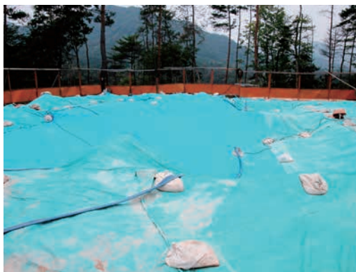
写真51 第1主体部の養生（3）
