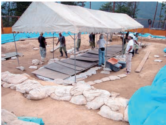
写真49 第1主体部の養生（1）
