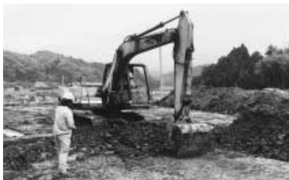
重機による表土除去
