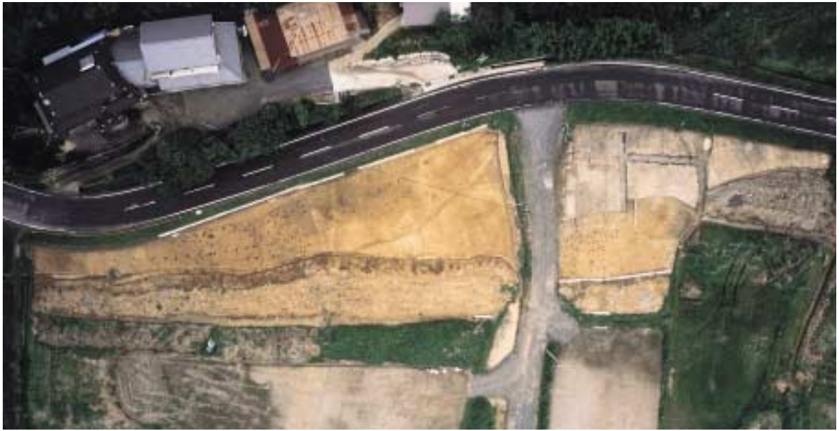
1 地区全景（東から）
