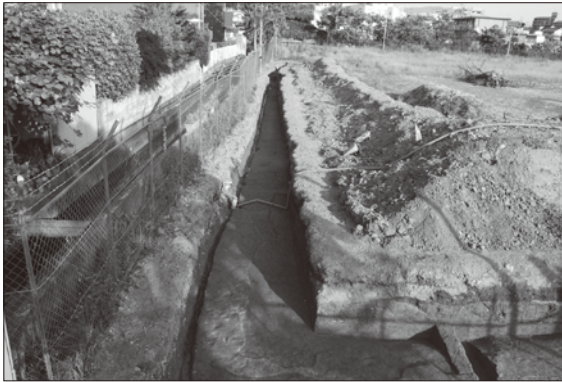
第27次:調査区全景〔北西から〕
