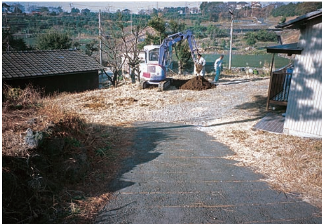
6. 5地区 重機掘削の様子 (東から)
