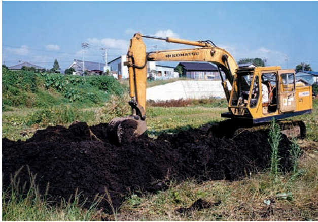
1. 3地区 重機掘削の様子
