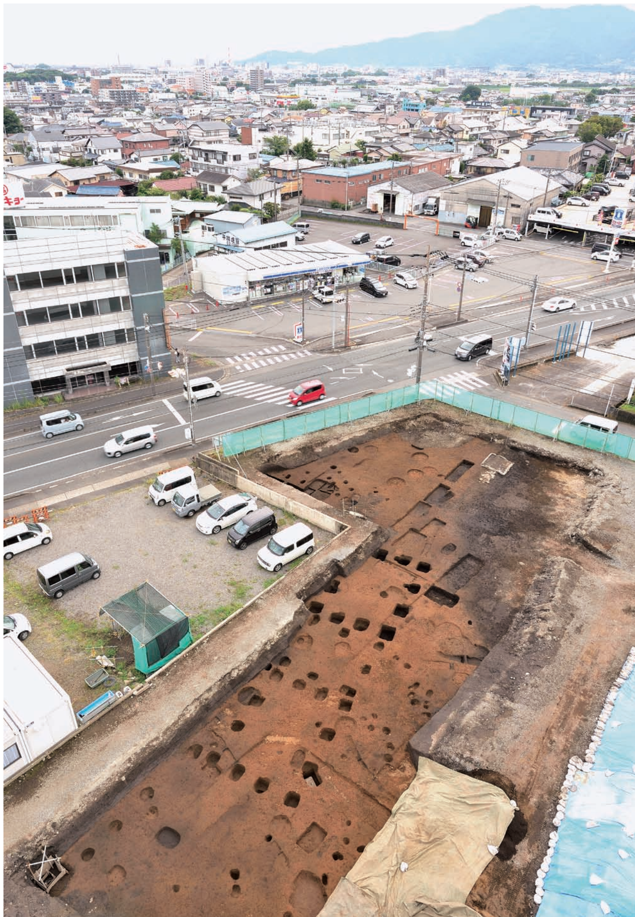
1. 3工区・4工区全景（北東から）
