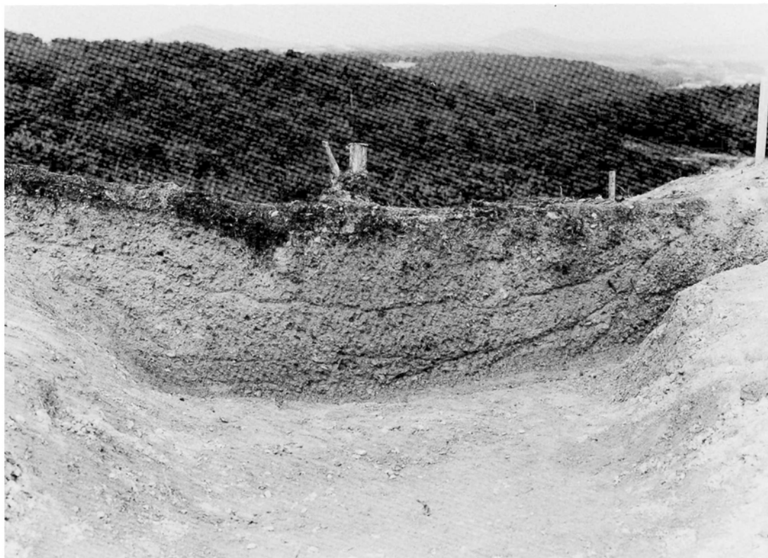
1. 溝土層断面(南西から)
