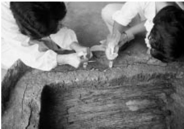
ひび割れの修復
