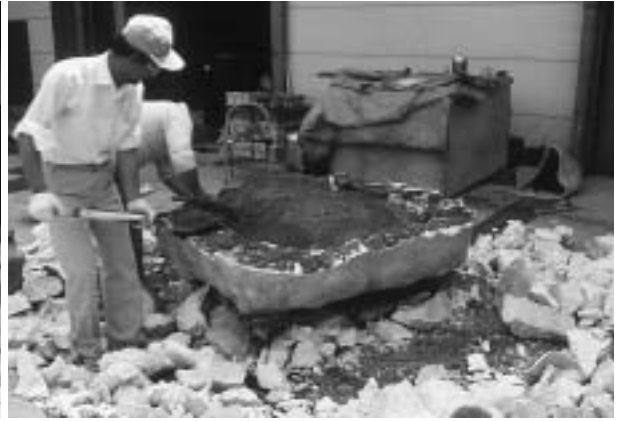
余分な土の除去
