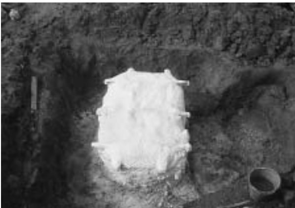
ウレタン吹き付け完了
