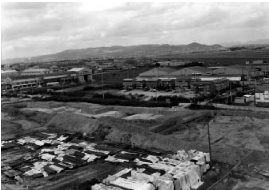
昭和56年度調査区全景 (南東から)
