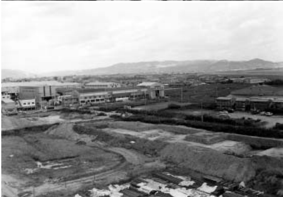
昭和56年度調査区全景 (南東から)
