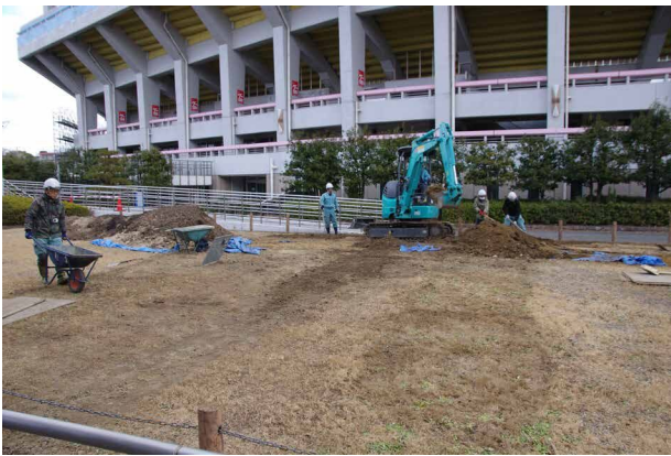
写真Ⅳ－47 埋め戻し作業
