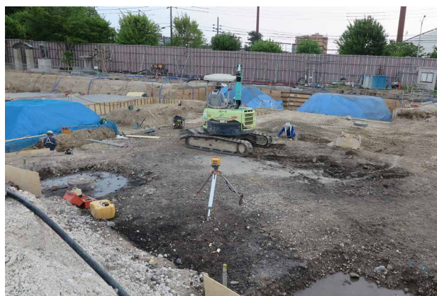
写真Ⅷ-1 シンダー層上面のフーチング床掘状況
