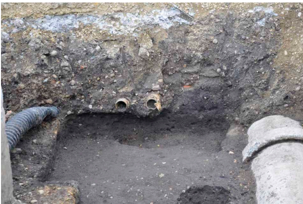
写真V-15 22C区 南壁 北から
