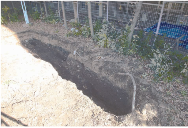
写真VI-1 61 トレンチ断面 南西から
