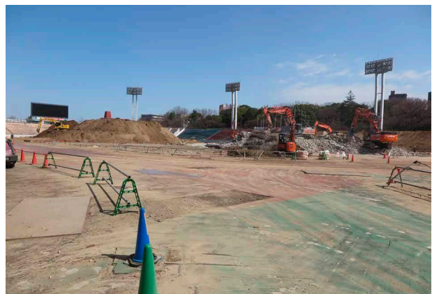
写真 II - 2 解体が進むスタジアム
