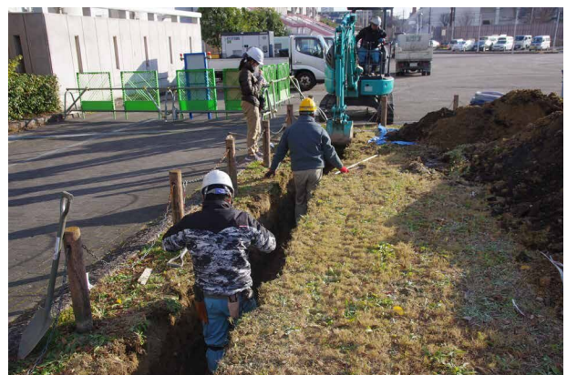
写真IV-7 表土除去作業
