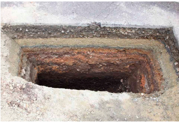
写真VI-3 66 トレンチ断面 北東から
