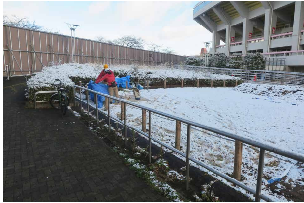
写真Ⅳ－32 作業風景
