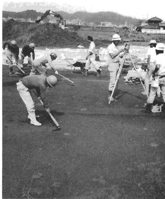
1. 重機掘削風景 2. 遺構検出風景
