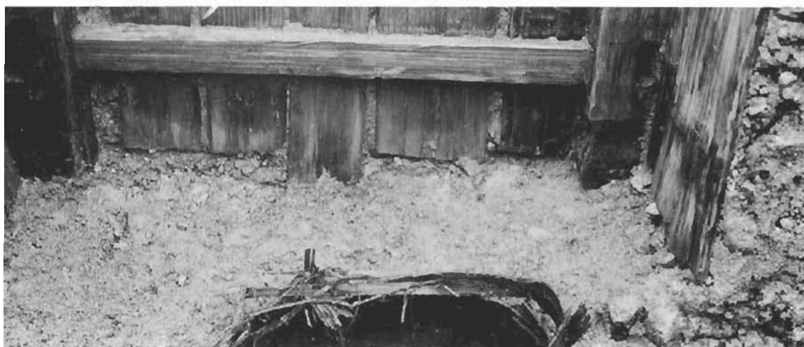
4. SE12 隅柱 東から
