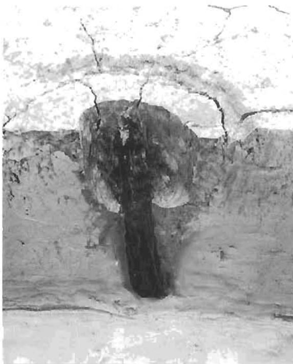
3. SH36 P2 断面 北東から
