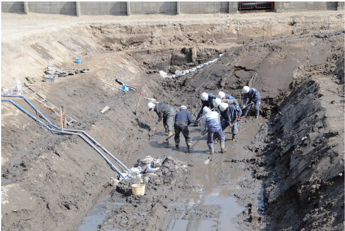
作業風景（西から）
