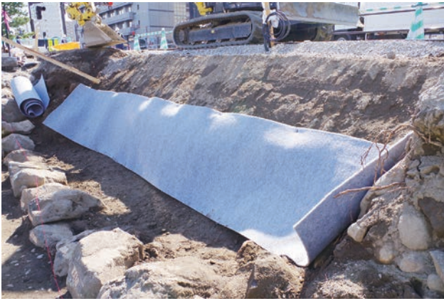
吸出し防止マット設置
