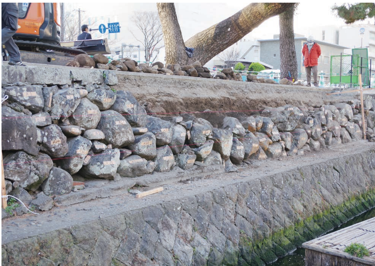
築石1段目解体状況
