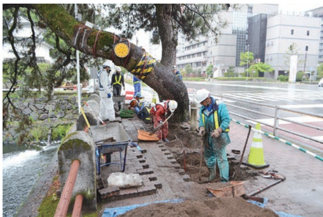
第34-1次調査（西から）
