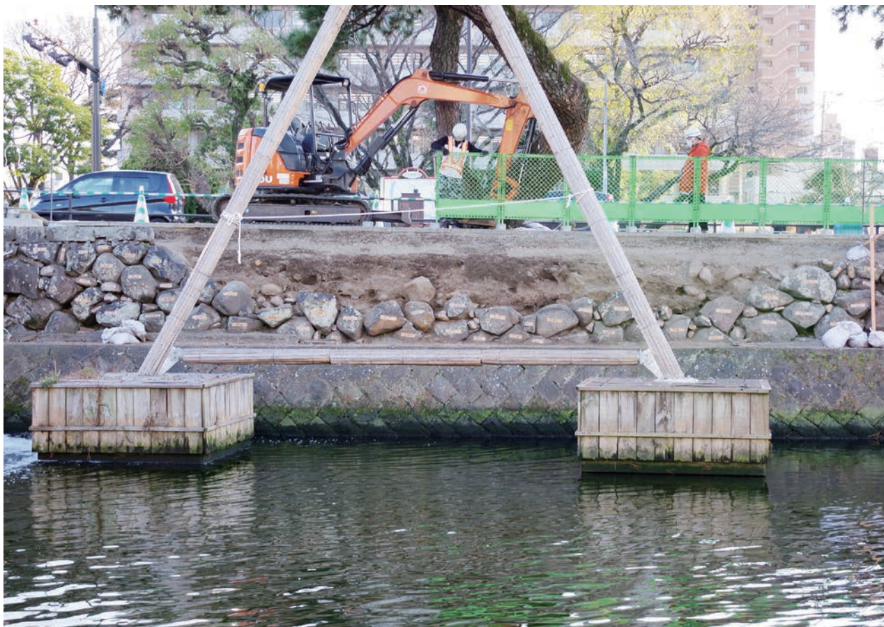
築石2段目解体状況
