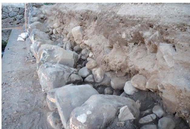
築石2段目解体状況（西から）
