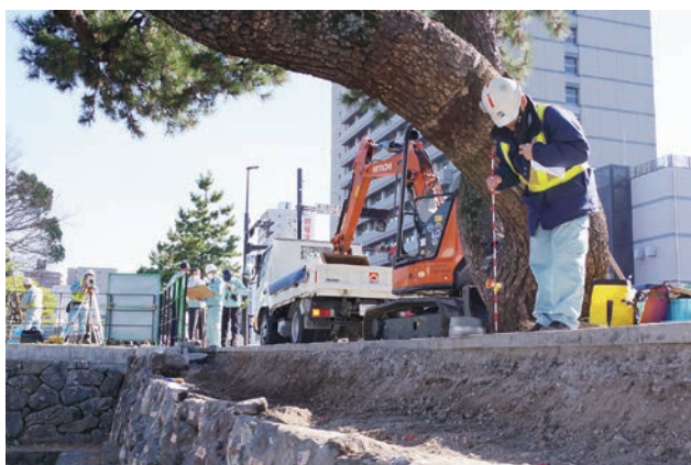
写真測量標定点観測作業
