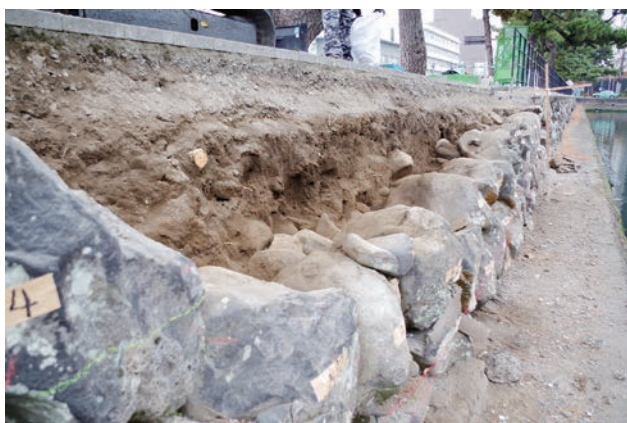
築石2段目解体状況（東から）
