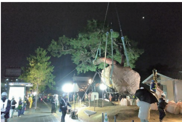
クロマツ移植作業（城址公園移植先）
