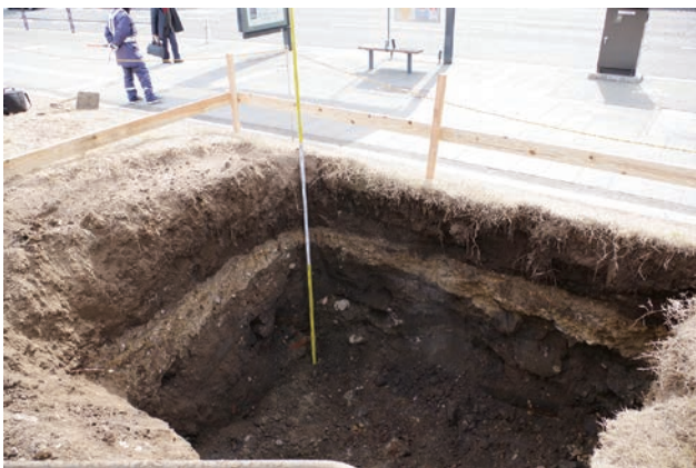
クロマツ移植先掘削状況
