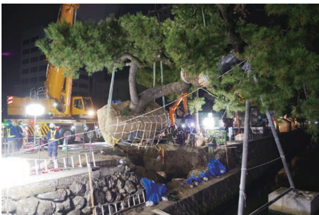
クロマツ移植作業
