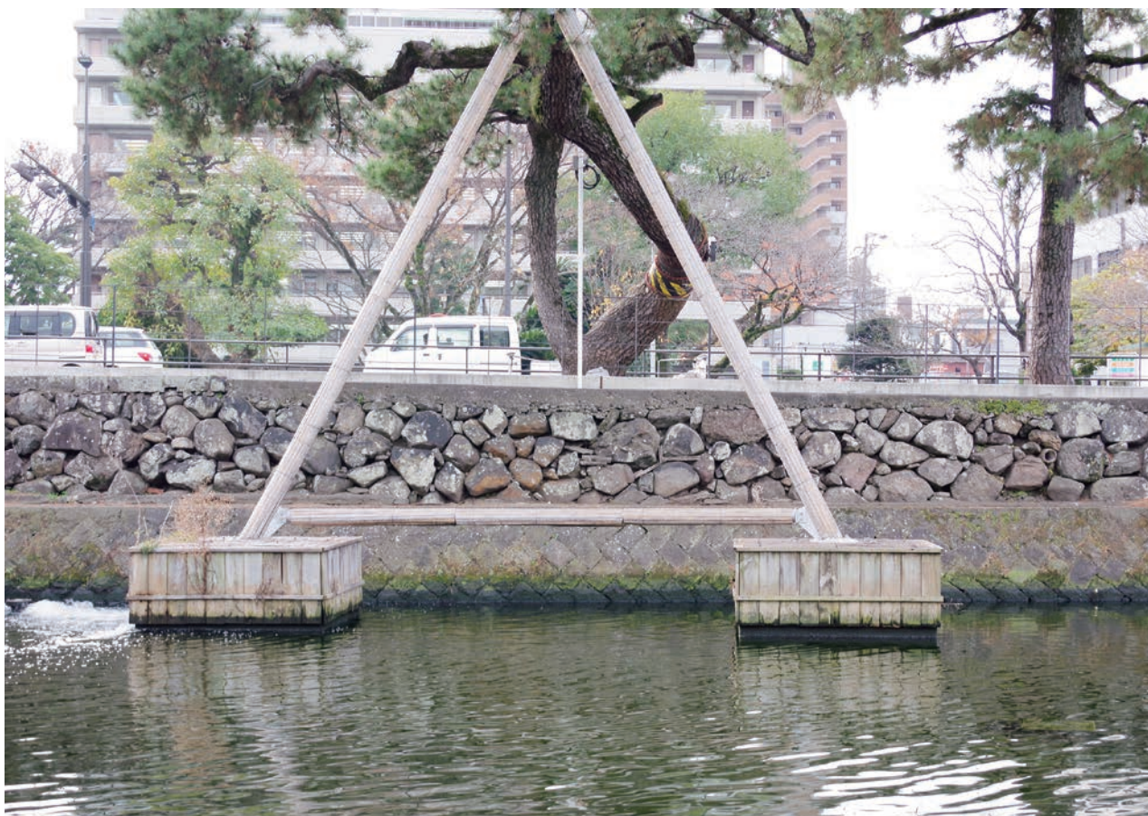
第34-4次調査 石垣解体前
