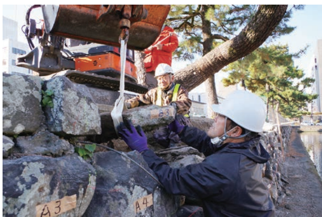
石垣解体作業
