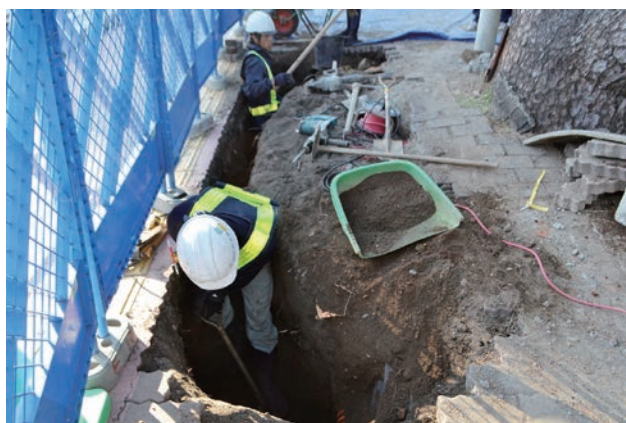
第34-3次調査南区掘削状況
