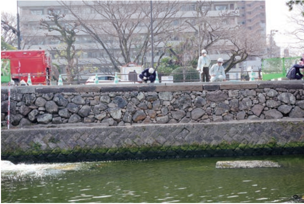
石垣復元完成
