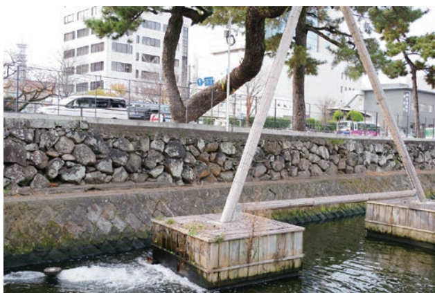
石垣解体前（北東から）
