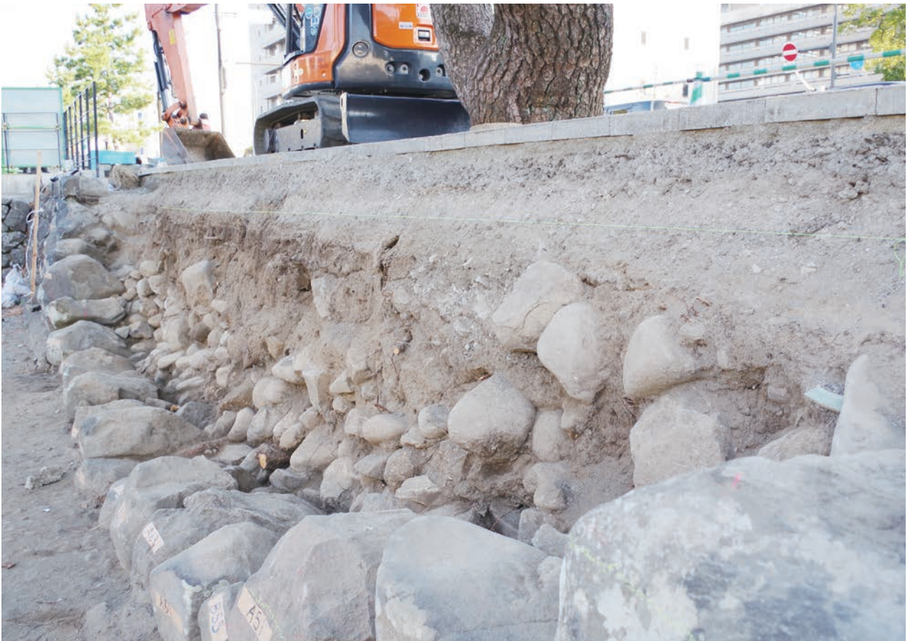
築石3段目解体状況及び土層断面（西から）
