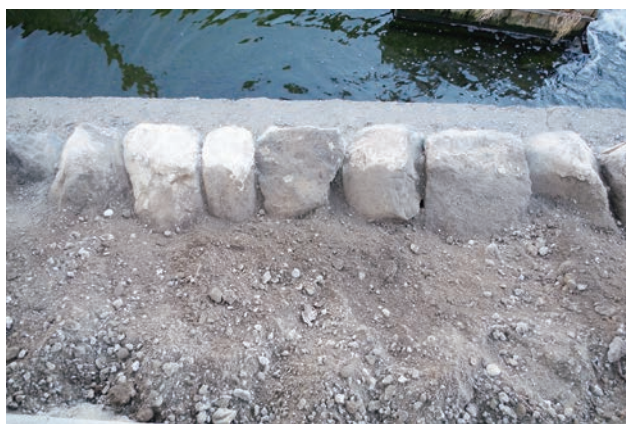
石垣天端石検出（南から）
