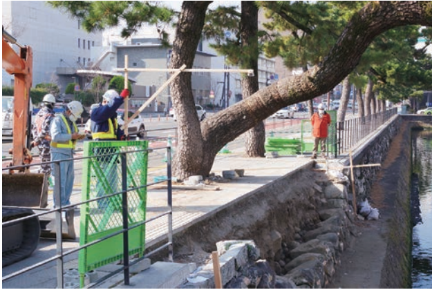
石垣解体面の写真測量
