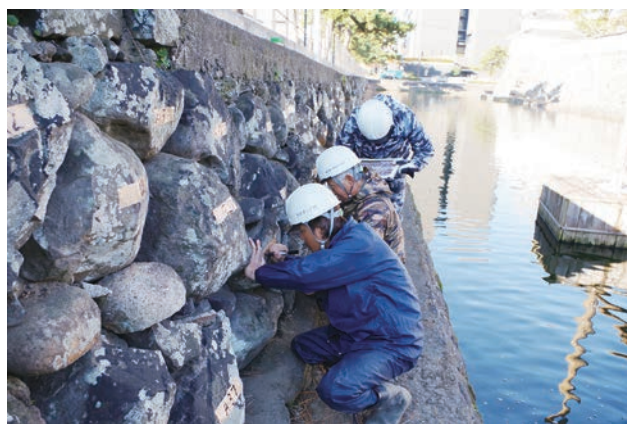
石垣番号付け作業
