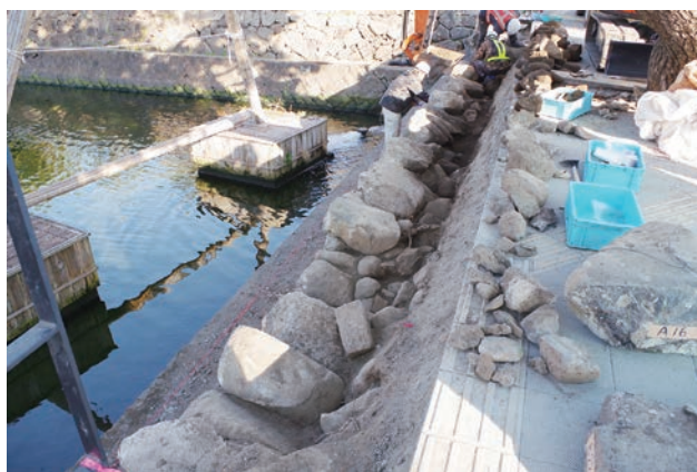
1段目裏込め発掘状況
