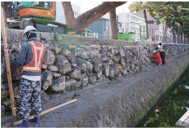
解体石垣の番号付け・丁張設置
