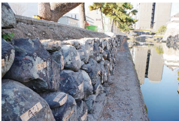
石垣天端石検出状況（東から）
