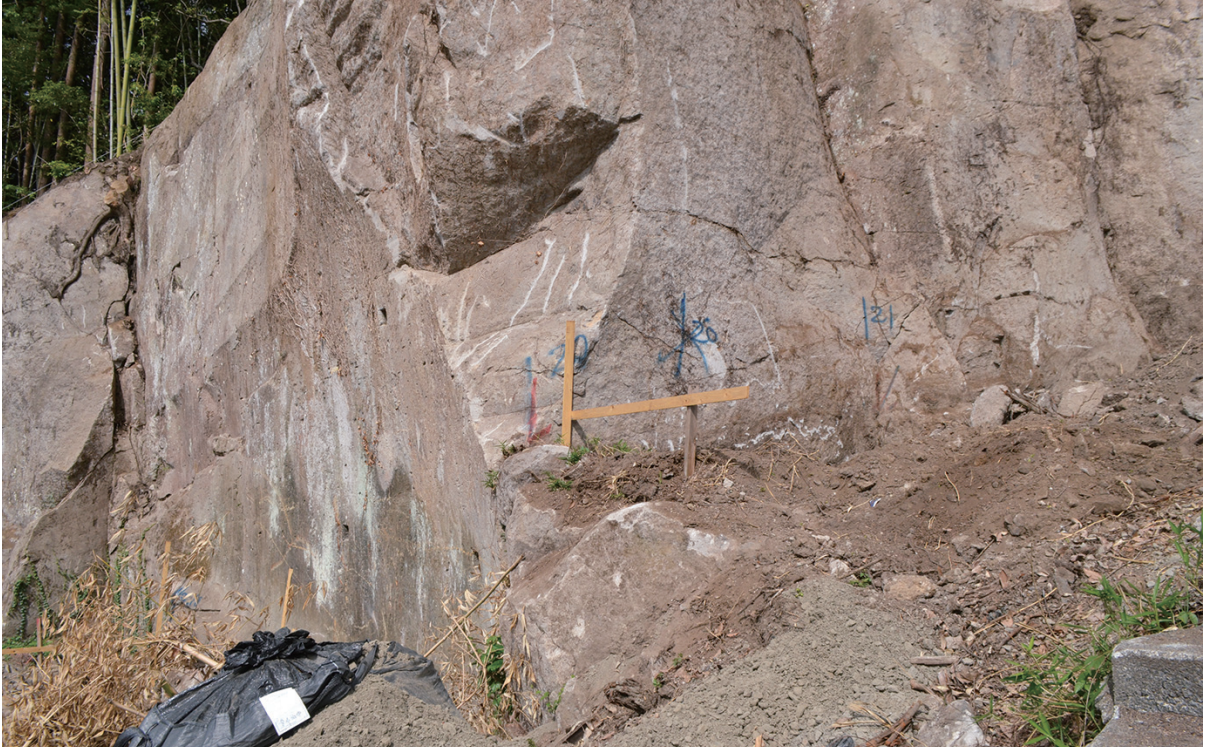
1区壁面（南東から）
