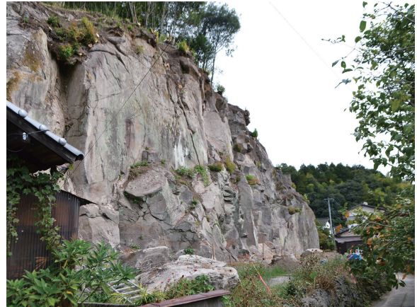
3区壁面（西から）
