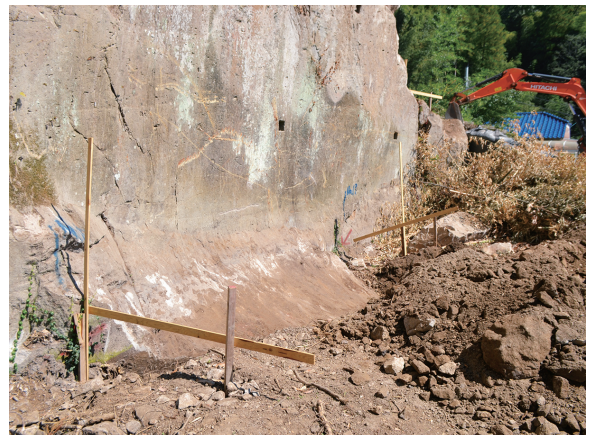
1区側溝部掘削状況
