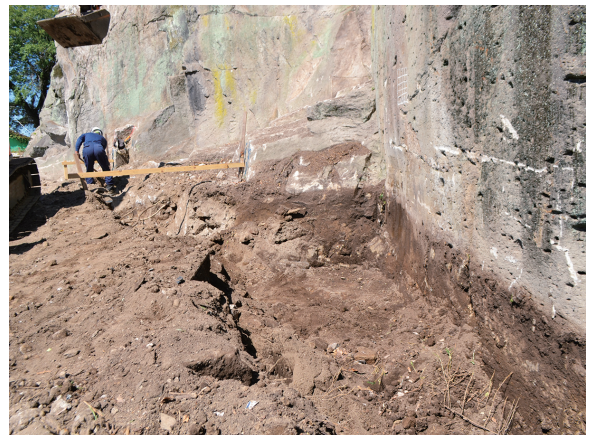
3区側溝部掘削状況
