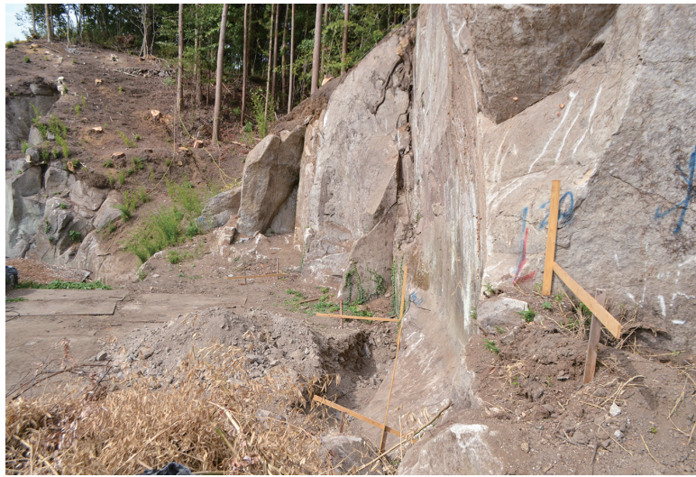
1区壁面（東から）
