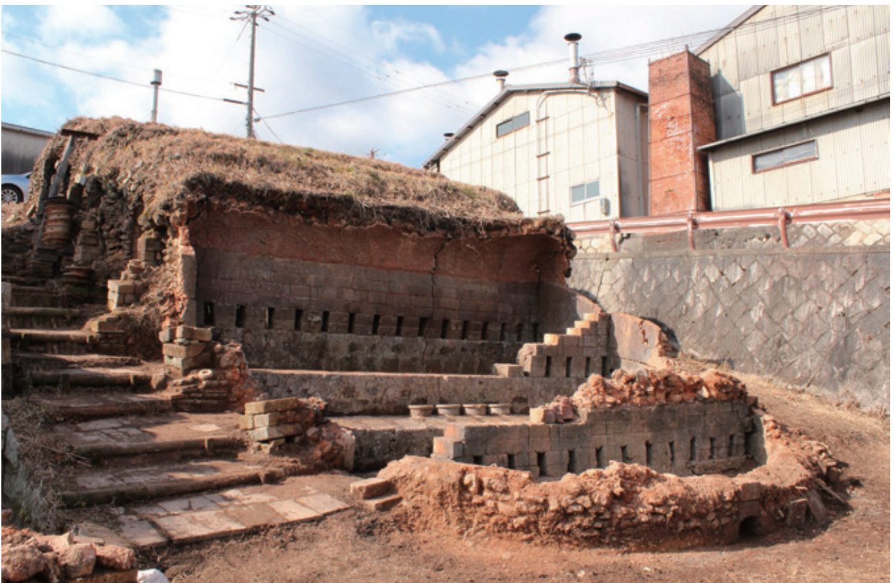
写真 43 : 22-10 次 崩落壁除去後（北西から）
