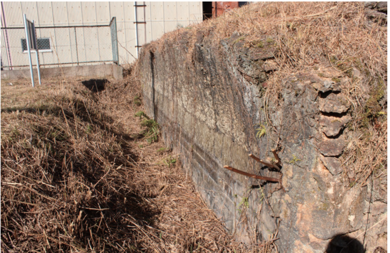
写真 49 : 22-10 次 背面残存状況
