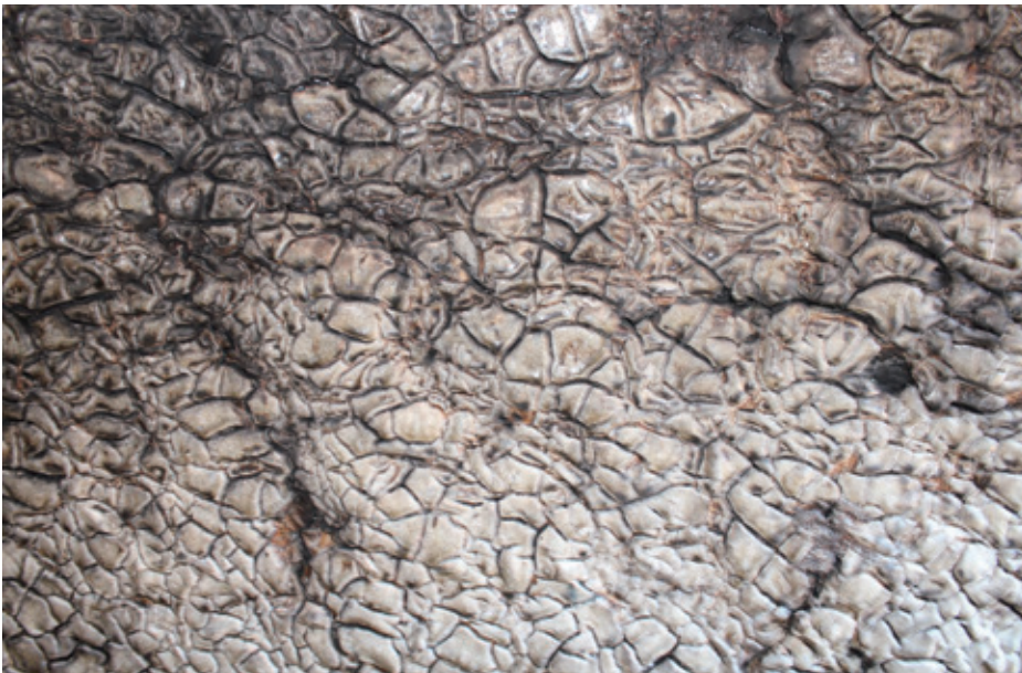
写真 57 : 22-10 次 焼成室内部壁面
