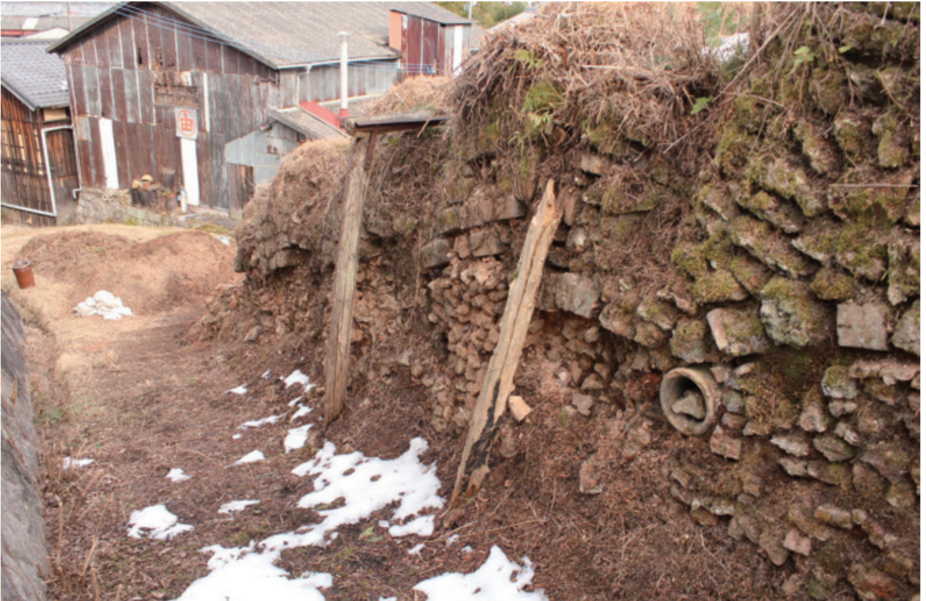
写真 46 : 22-10 次 残存する覆屋の支柱
