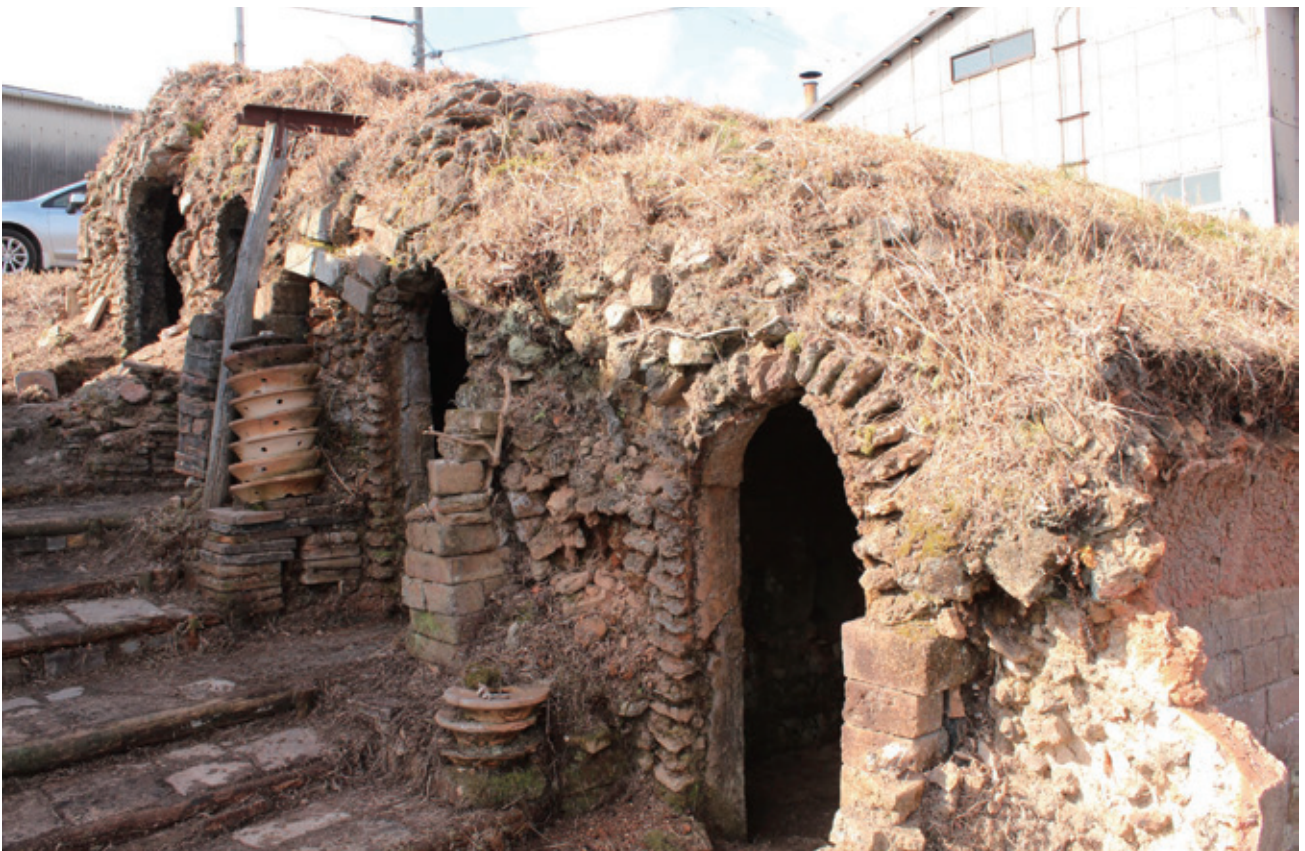
写真 45 : 22-10 次 残存する焼成室入口
