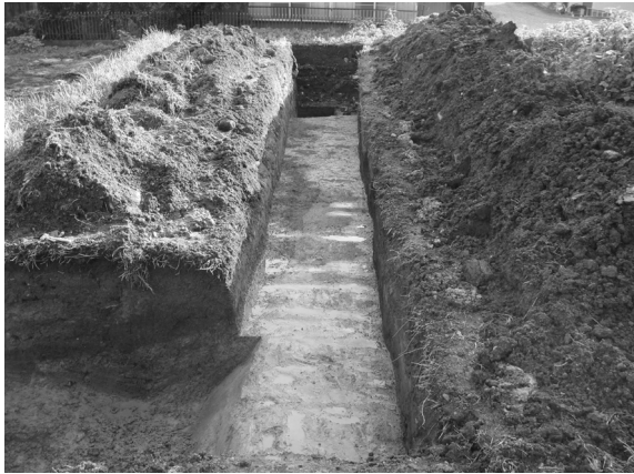
写真 16 2 トレンチ全景（北から）
