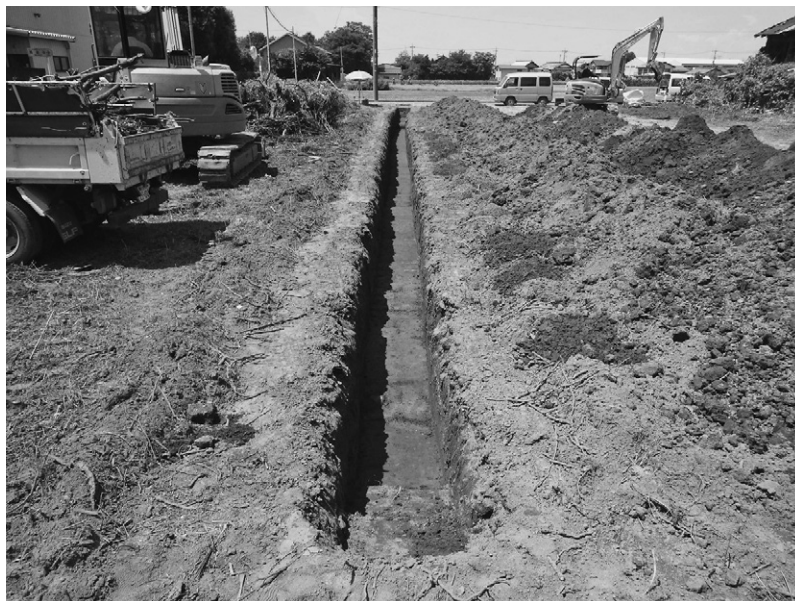
1 R 1 - No.293 FP 泥流下遺跡群 (東から)
