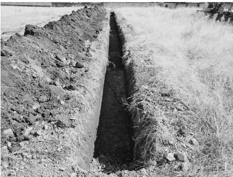
30 R 1 - No.572 鳥山宿屋敷遺跡（西から）
