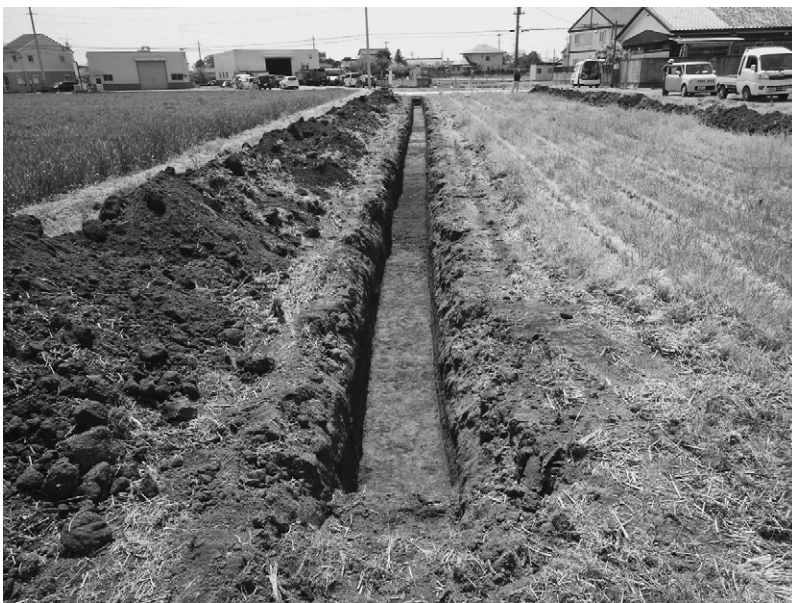
21 R 1 - No.26 杉ノ下遺跡（北東から）
