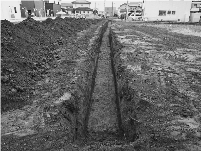
52 R 1 - No.750 FP 泥流下遺跡群（北から）
