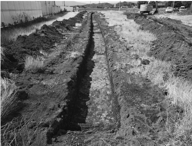
29 R 1 - No.36 鳥山下遺跡（南東から）
