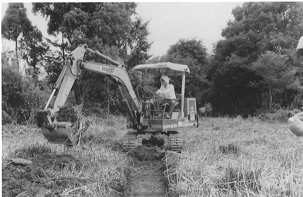
6 トレンチ排土作業
