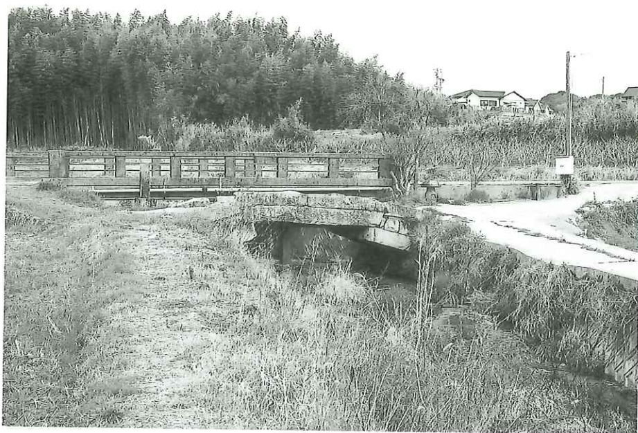
石造十六橋近景 (南西から)
