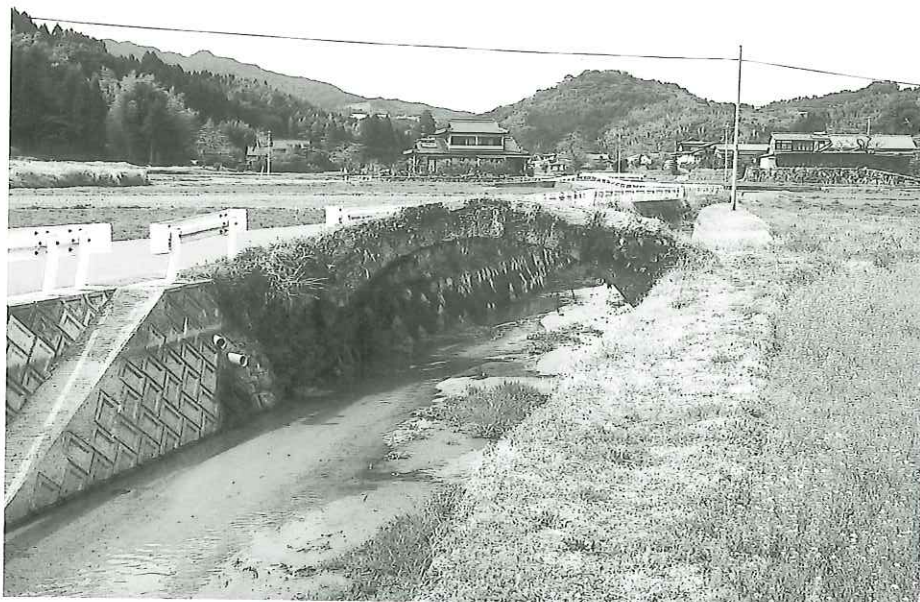
石貫車橋 (南西から)
