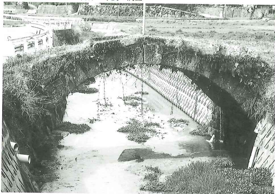
石貫車橋近景 (南西から)
