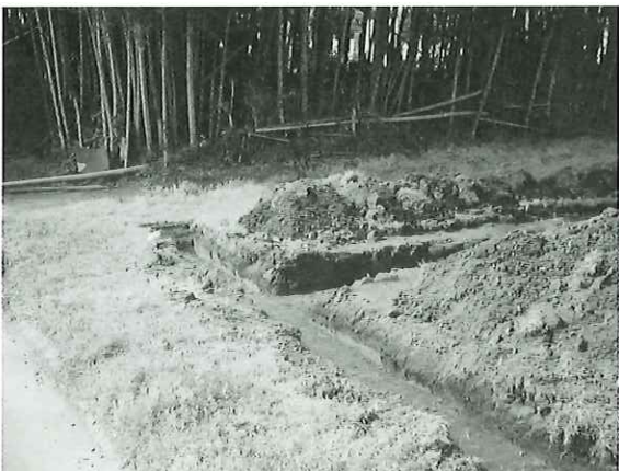
中村館跡トレンチ東側(北から)
