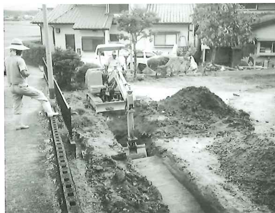
永安寺跡・永安寺古塔碑群調査状況(北から)
