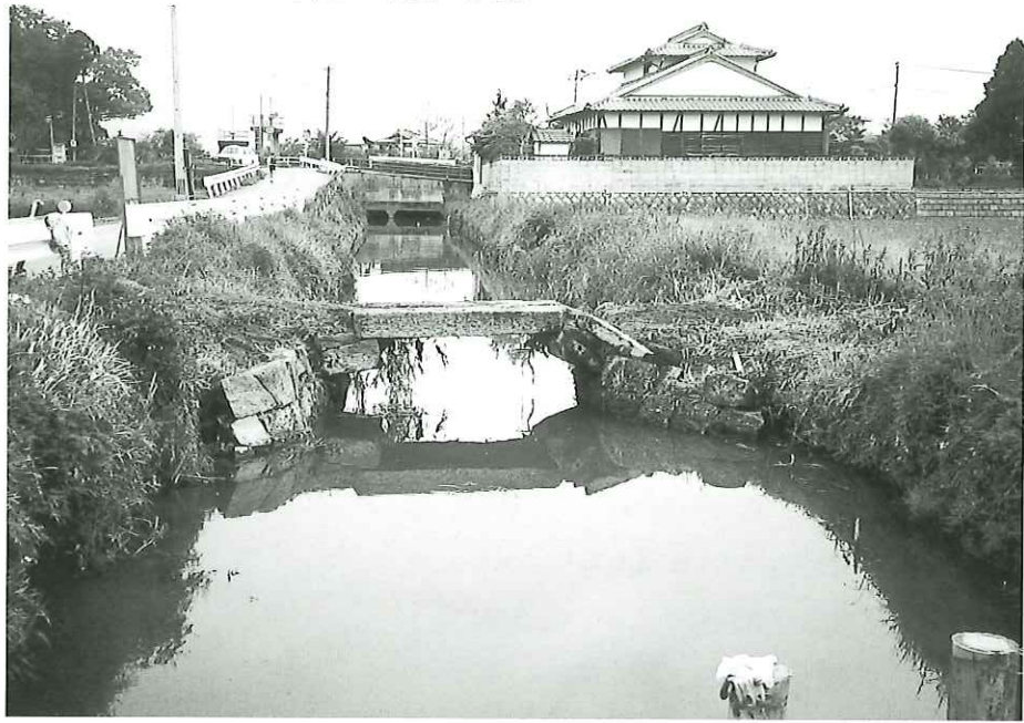
乙宮橋近景 (西から)
