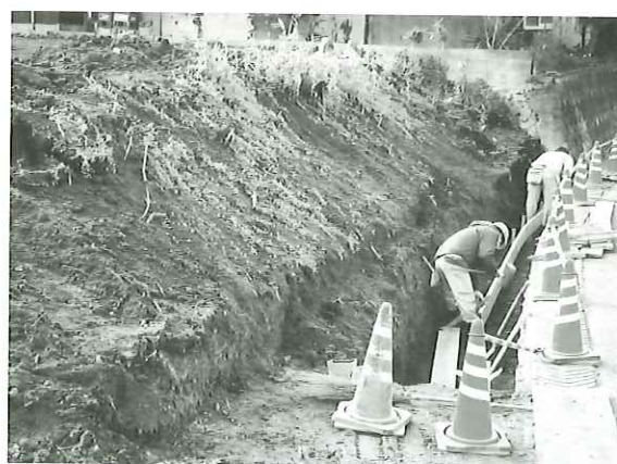
田嶋遺跡A地点北側擁壁工事状況
