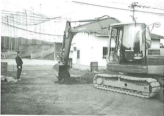
築地市場遺跡調査状況(南から)
