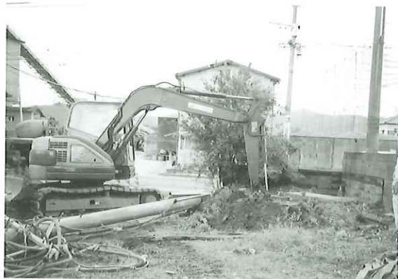
築地市場遺跡調査状況(南から)
