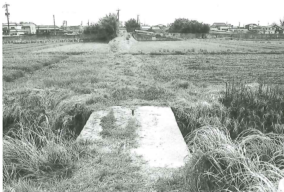
乙宮橋修復後
