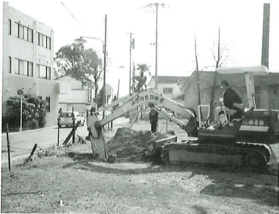
ふれあい広場建設予定地調査状況
