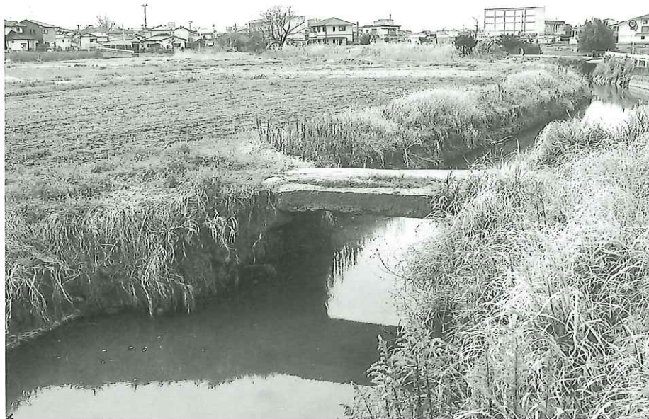
乙宮橋修復後 (東から)
