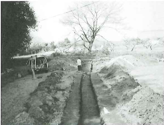
中村館跡調査状況(東から)
