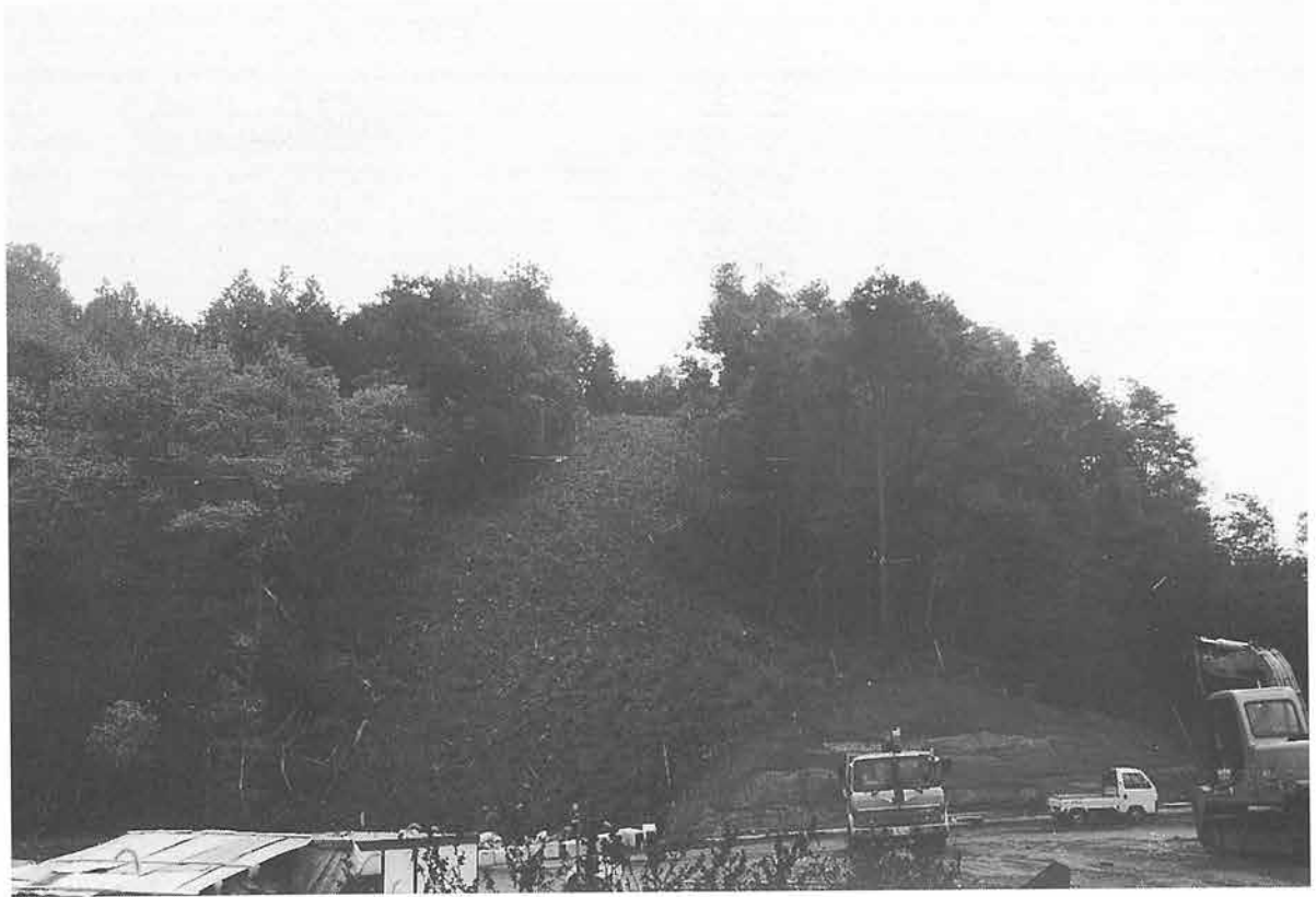
1. 第2次調査地遠景(北から)
