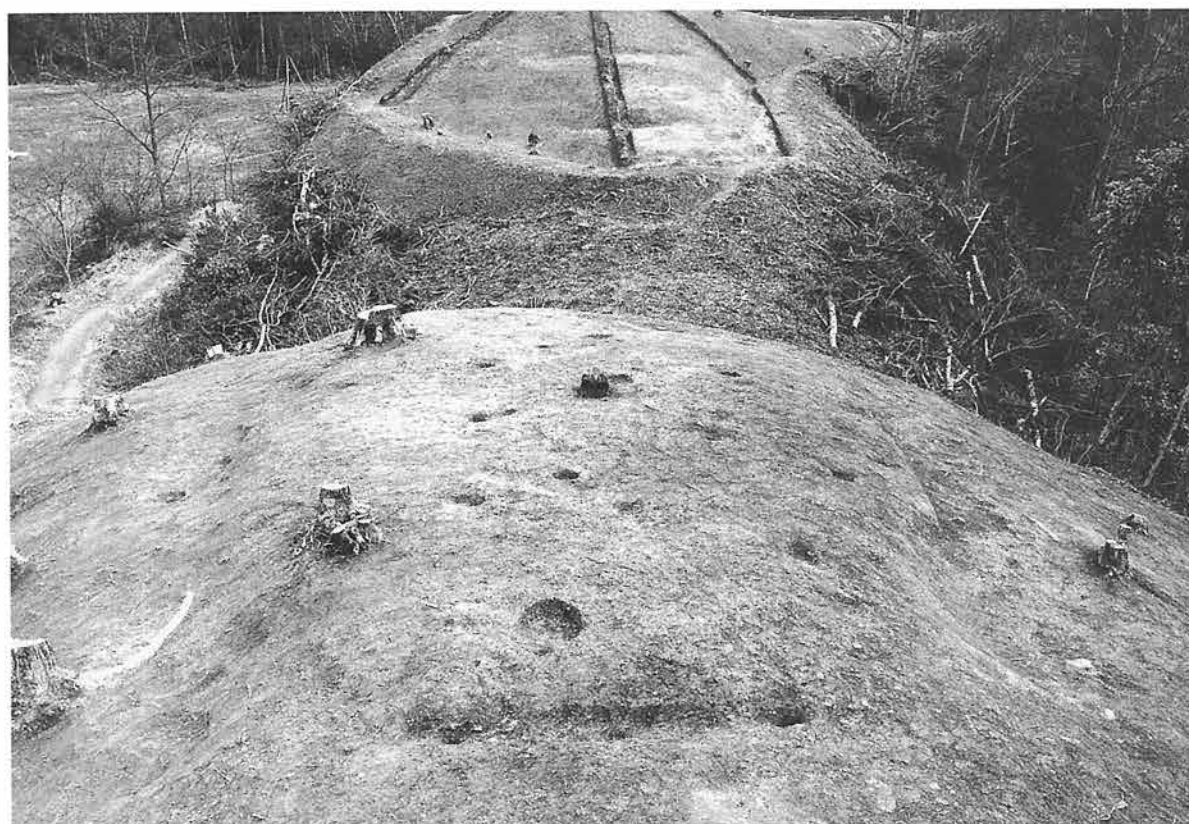
2. 平坦地4(北西から)
