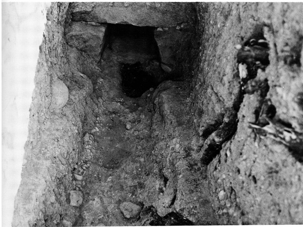
本丸排水施設入口（西から）
