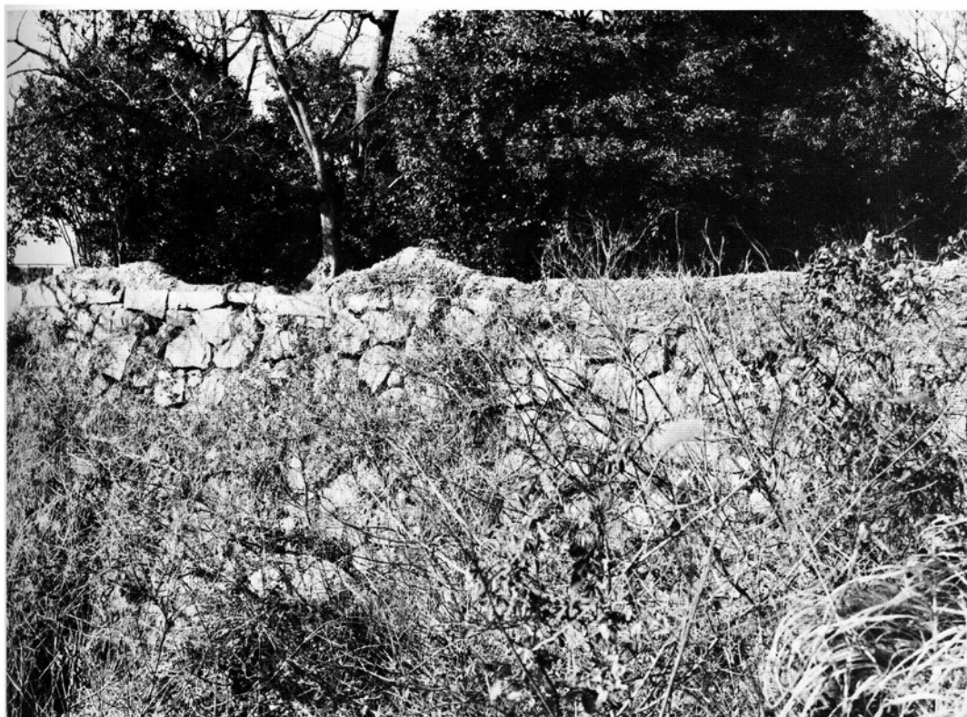
箱堀の土塀（北東から）
