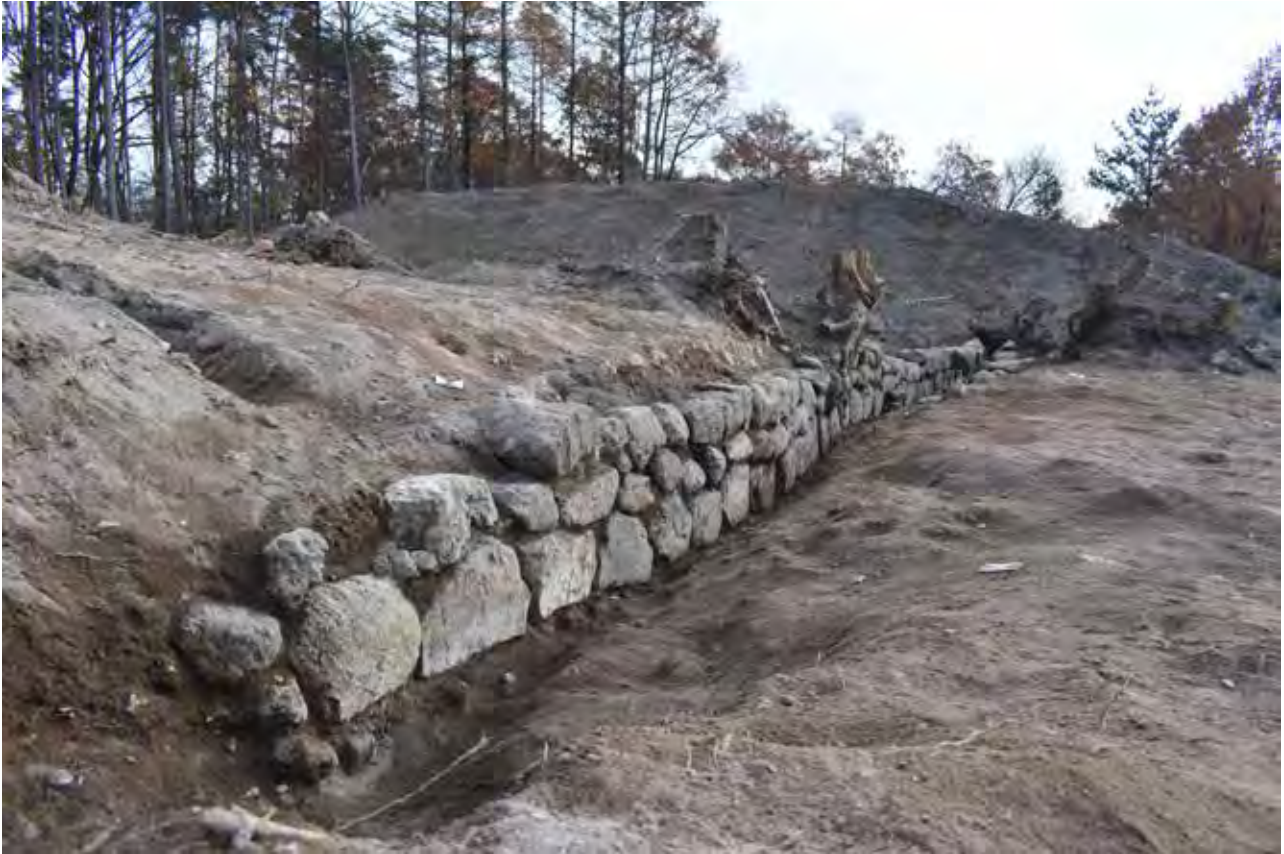
SD1 東側石積み（西から）
