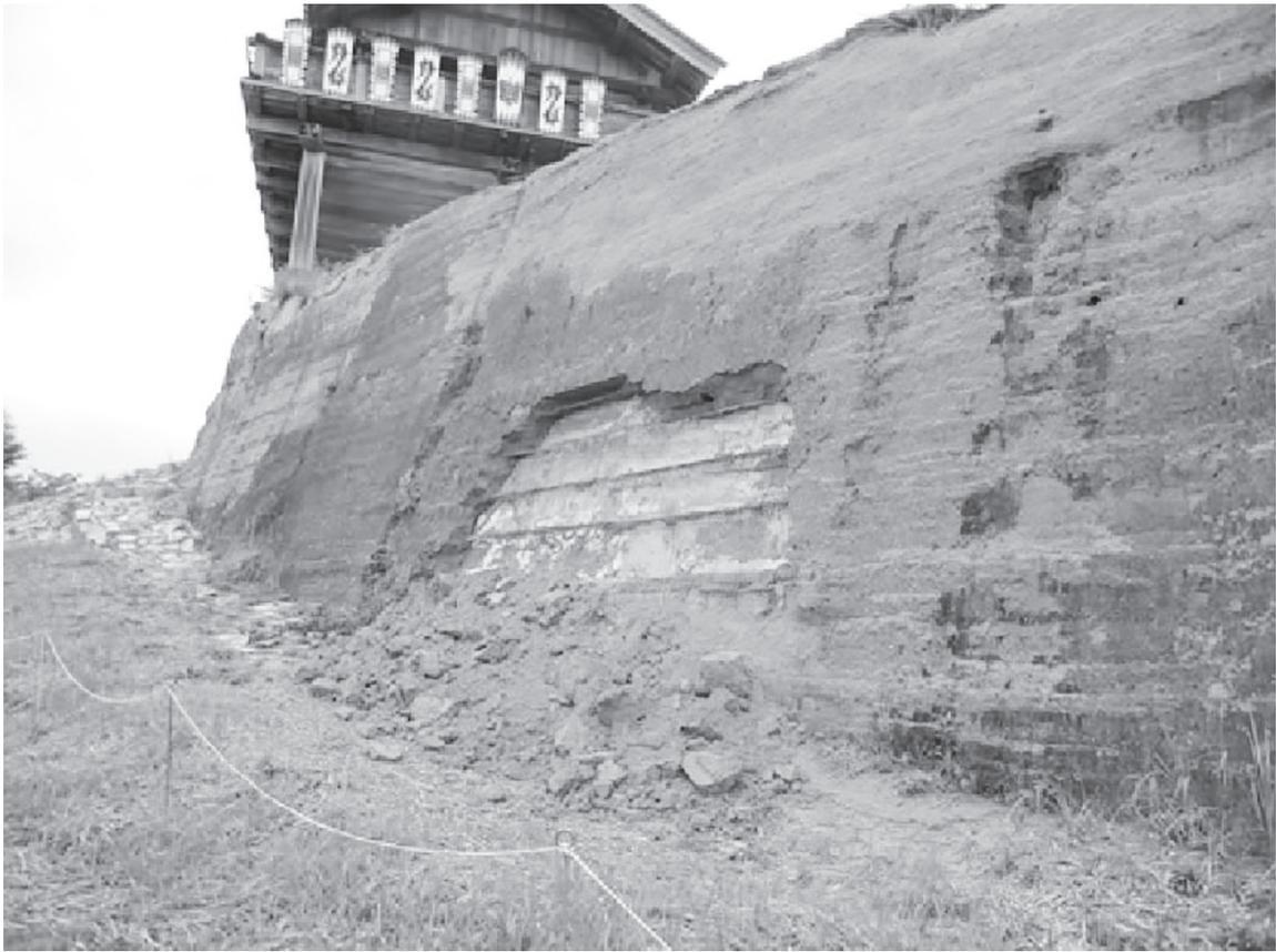
写真52 土塁崩落状況（東から）
