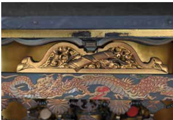
(挿図6) 厨子の長押及び欄間
