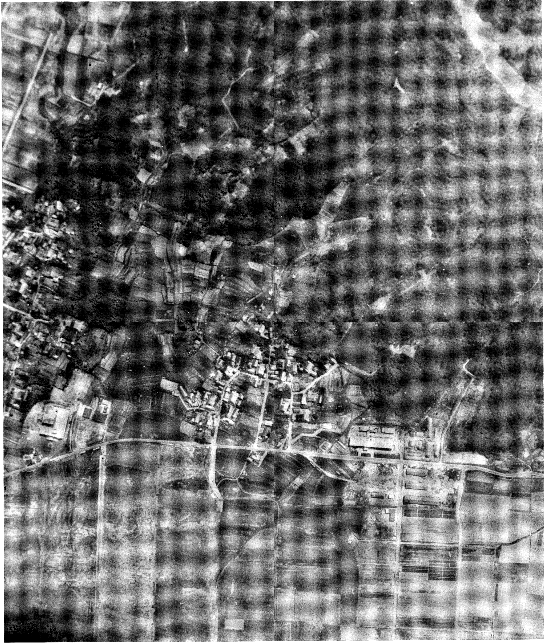
図版1 伊勢谷(左) 湯谷(右)全景 (北より)
