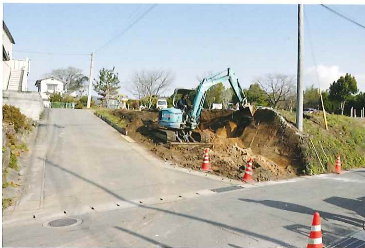
11 A区周辺掘削状況（南から）
