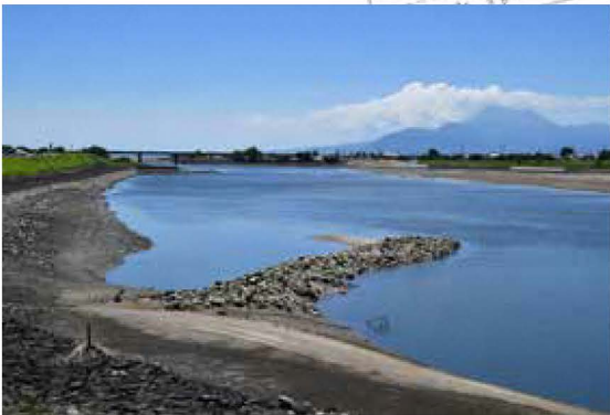
菊池川に長く突き出た、流れを制御するためのハネ
