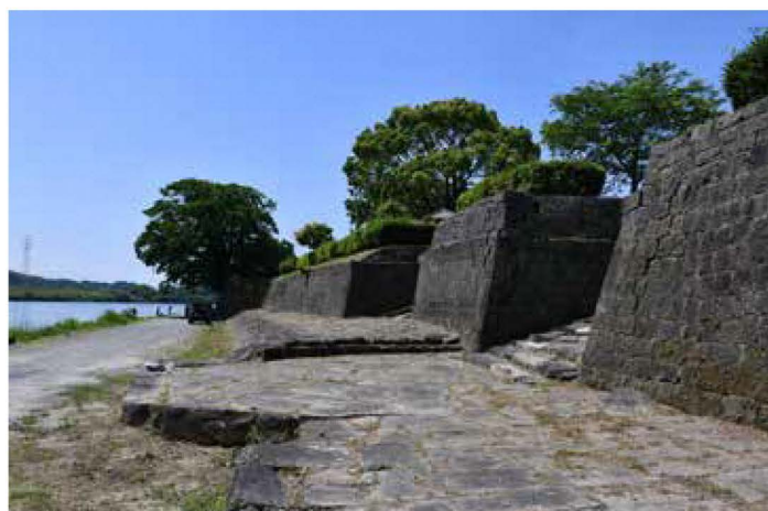
高瀬船着場跡旧頭渡 (北から)
