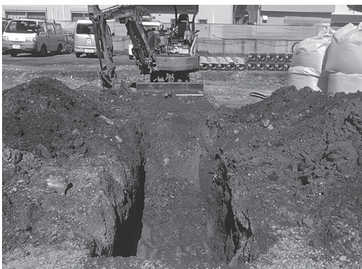
トレンチ全景 (南東から)
