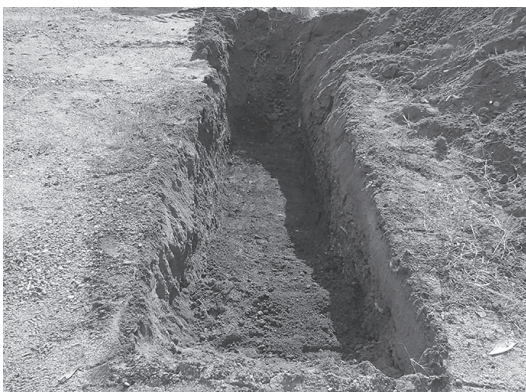
トレンチ全景 (南東から)
