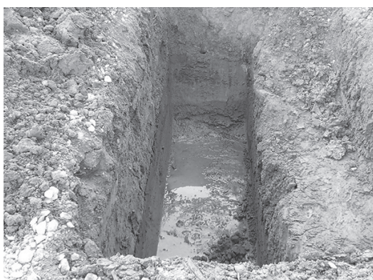
トレンチ全景（西から）
