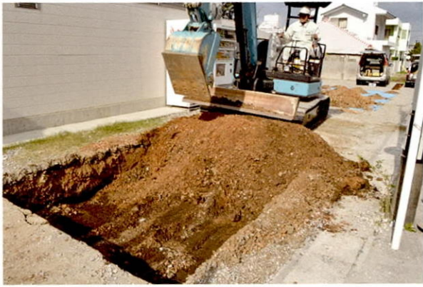
1. 表土掘削作業
