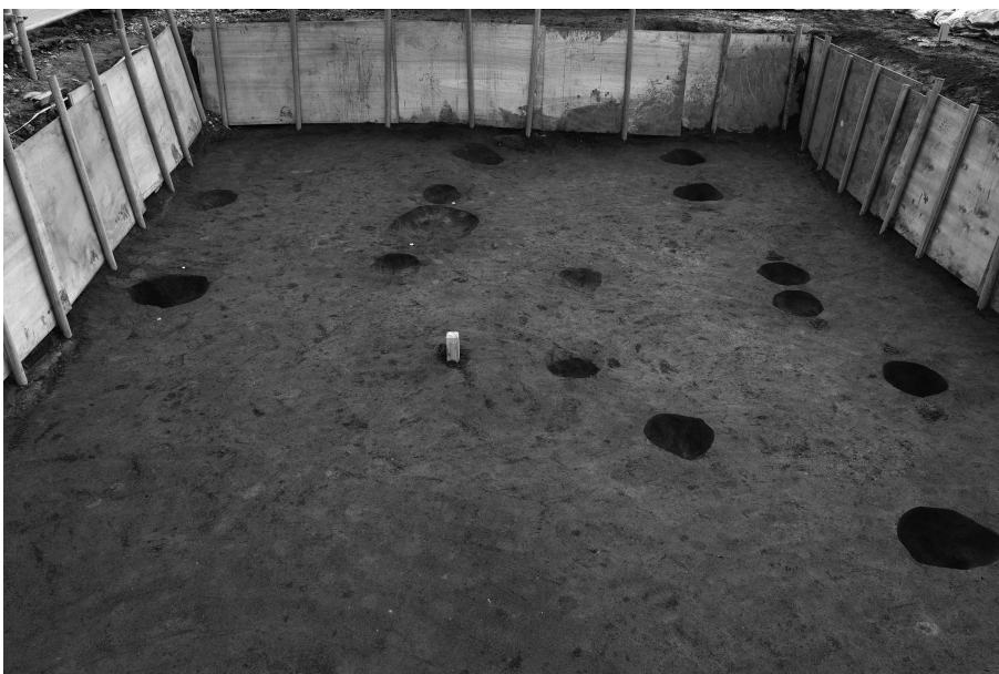
第 1857-6 図 北側完掘全景(南)
