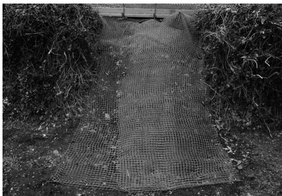
(4) 2 トレンチ埋め戻し状況（東から）
