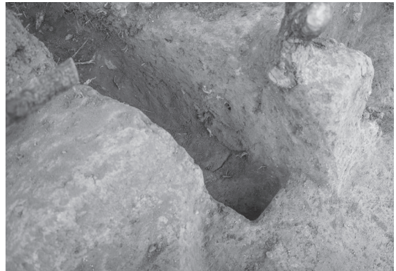
(8) 柱穴 SK05 断ち割り状況 (南東から)
