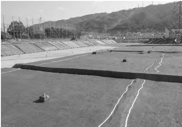
第10 a層上面 282 畦畔 (南西から)
