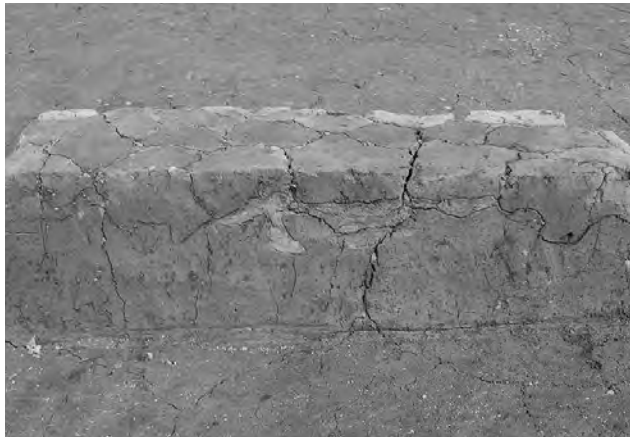
第11 - 1 a層上面 289 擬似畦畔 断面 (西から)
