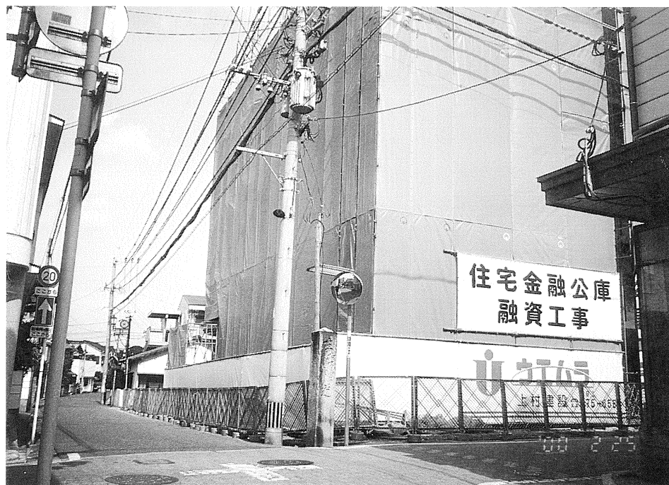
現地に残された唐津街道標石と建設中のマンション
