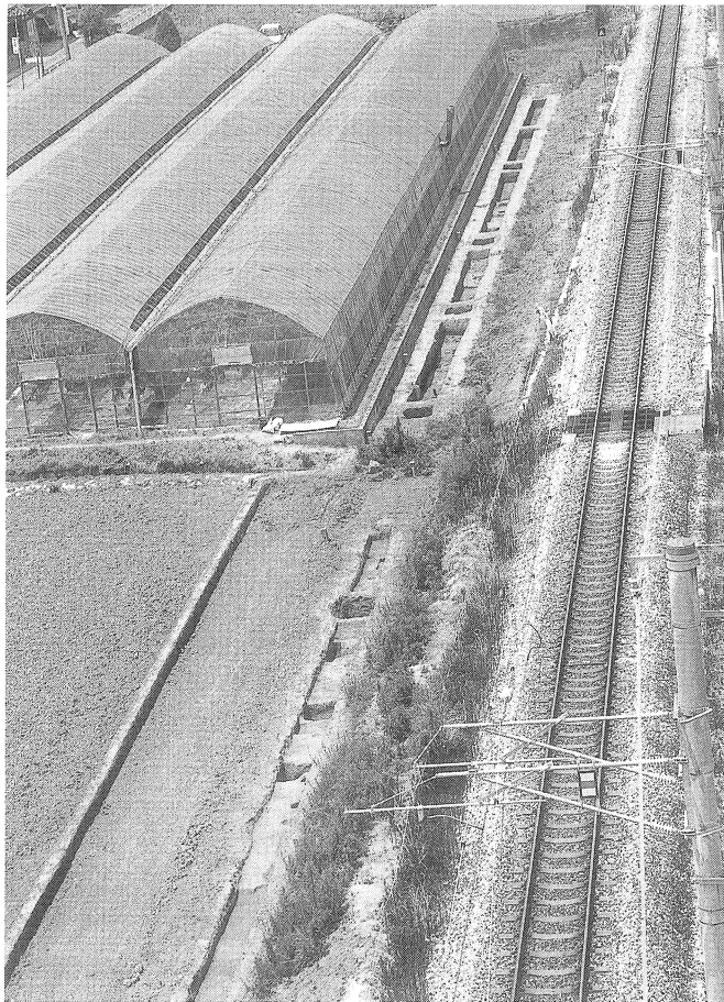
a 1-B調査区全景 (北東から)
