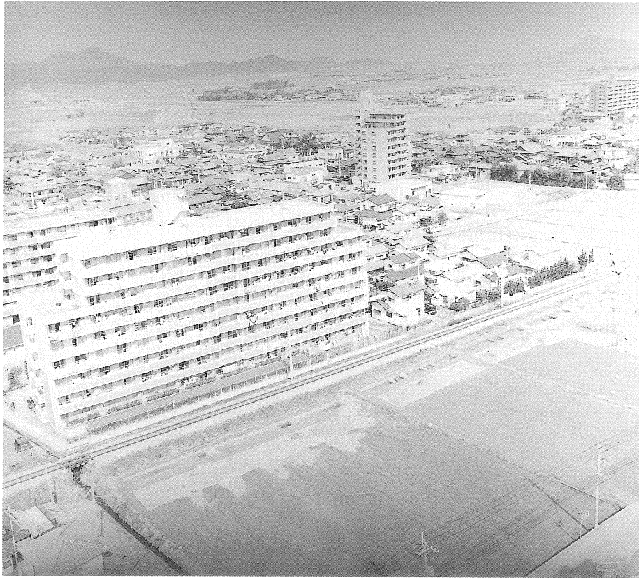
a 3調査区全景（南から）
