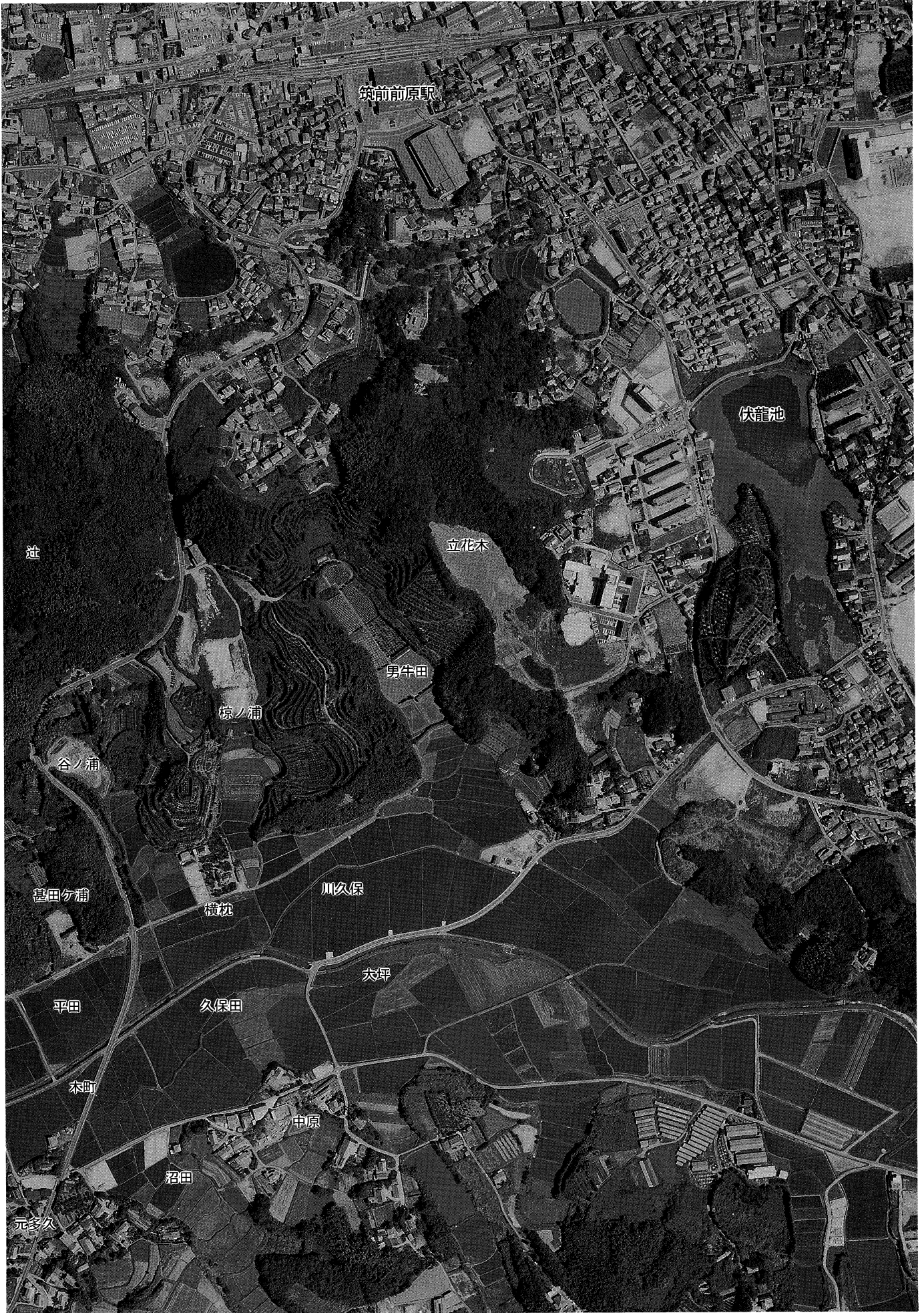
荻浦地区周辺工事着工前現況航空写真 (1/5,000)
