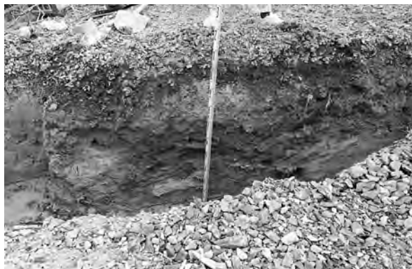
下水管工事断面（西から）
