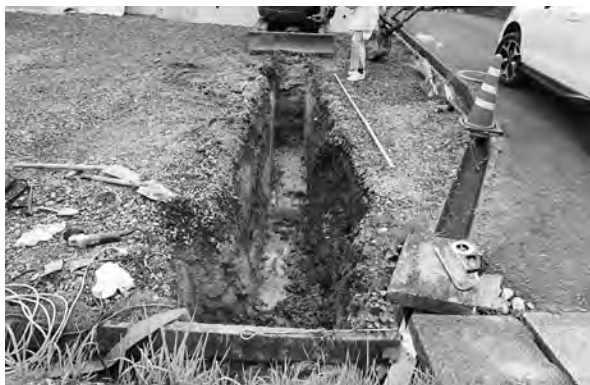
下水管工事（北から）
