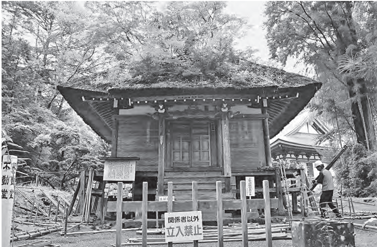
姫待不動堂 解体前現状（南から）
