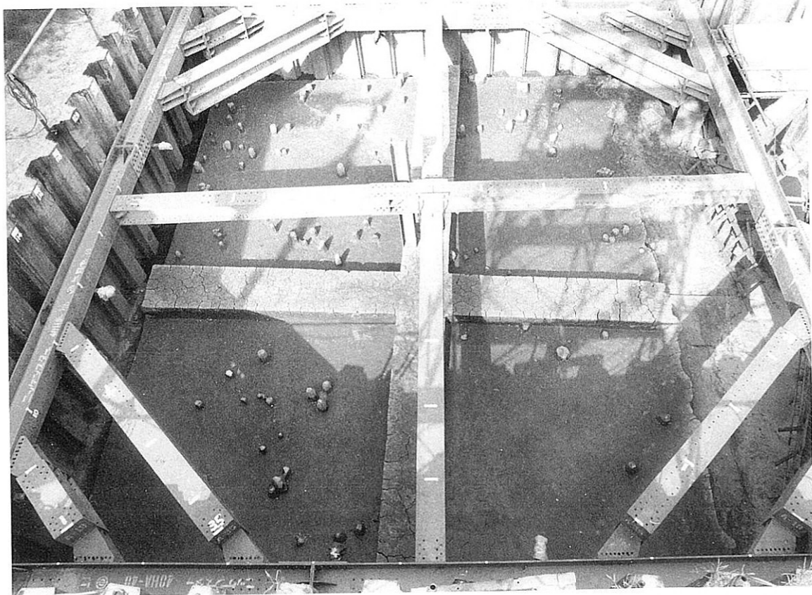
晩期包含層遺物出土状況Aトレンチ（南から）
