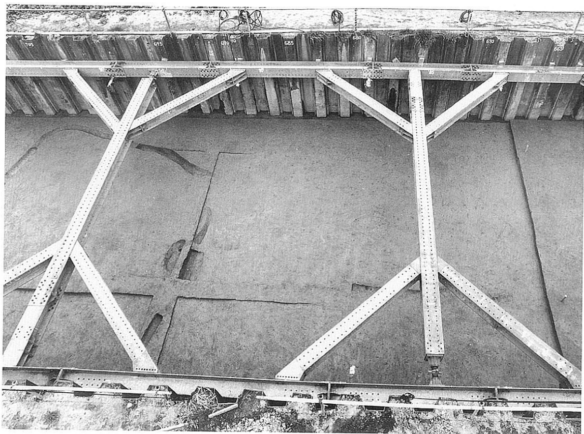
23～26ライン遺構面全景（東から）
