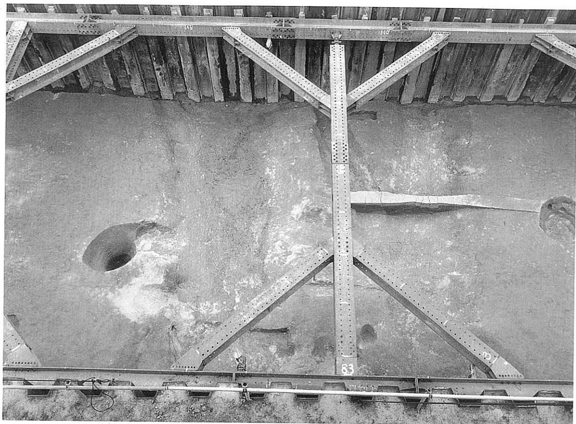
33～36ライン遺構面全景（東から）
