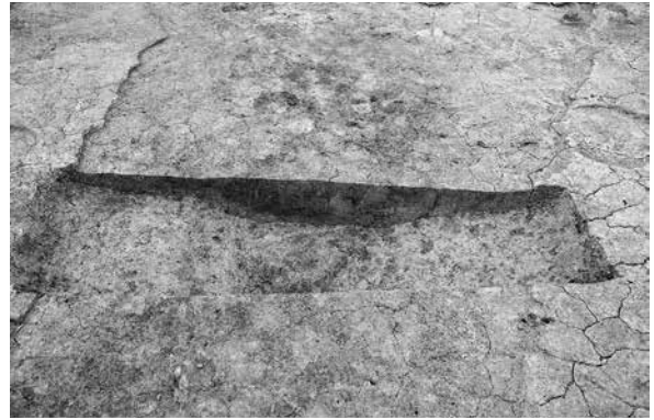
84SD17 旧 断面 (東から)
