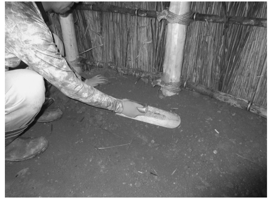
土間・周堤の復旧 (1号棟)
