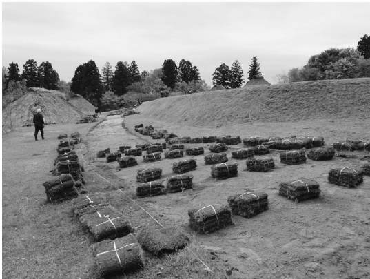
芝生修繕作業風景（令和5年4月）
