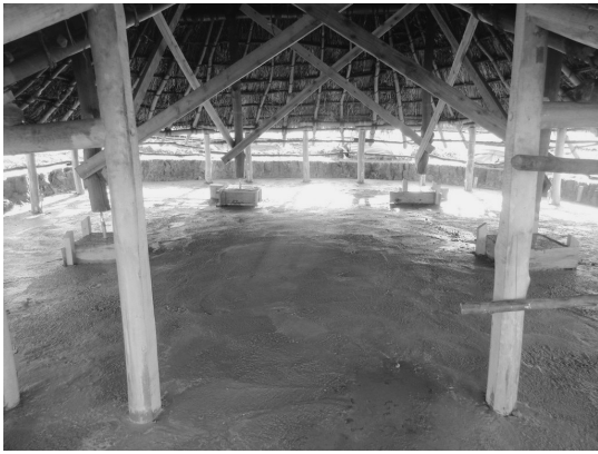
土間・周堤下コンクリートのベタ基礎新設 (1号棟)
