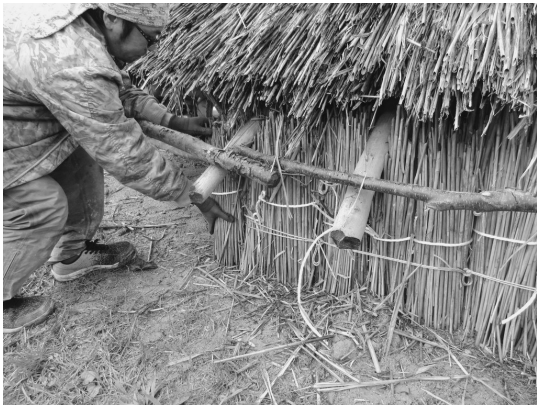
茅葺の復旧 (1号棟)
