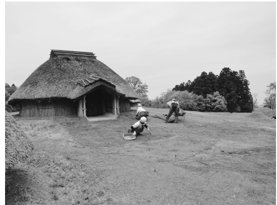
芝生修繕作業風景（令和5年4月）
