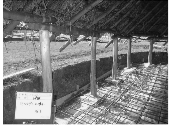
屋根ジャッキアップ、茅葺下部撤去、土間・周堤掘削、鉄筋設置、ゲヤ柱交換・防腐処理など (1号棟)
