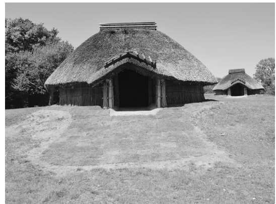
芝生修繕作業後（3号棟 令和5年4月）
