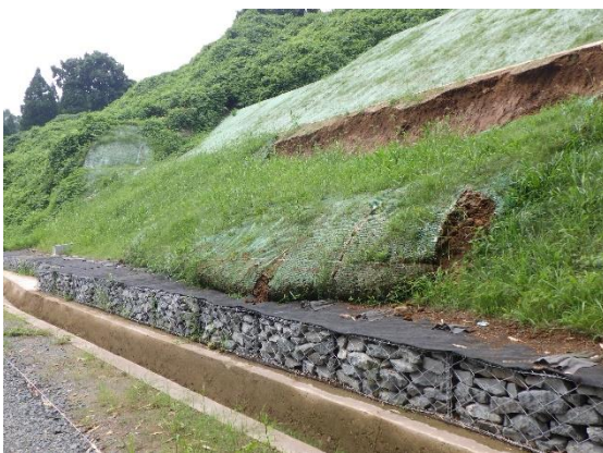
崩落箇所（左復旧前、右復旧後）
