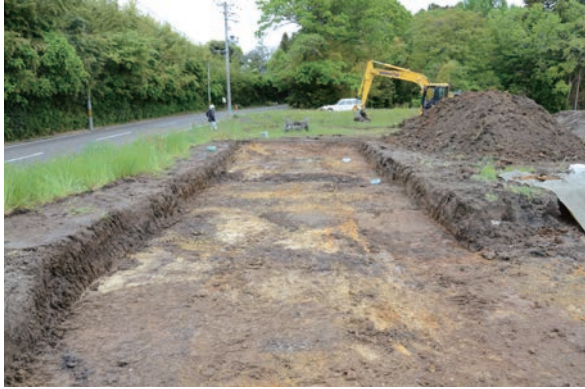
1. 重機による表土除去(南から) Z9157
