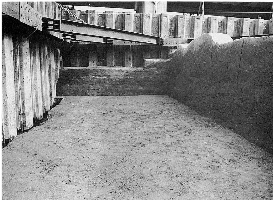
Bトレンチ 右岸堤防土層断面
