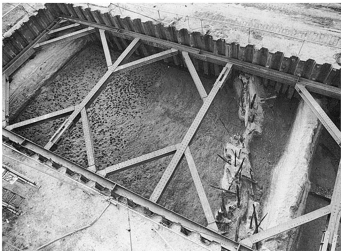
Fトレンチ 足跡、護岸杭列
