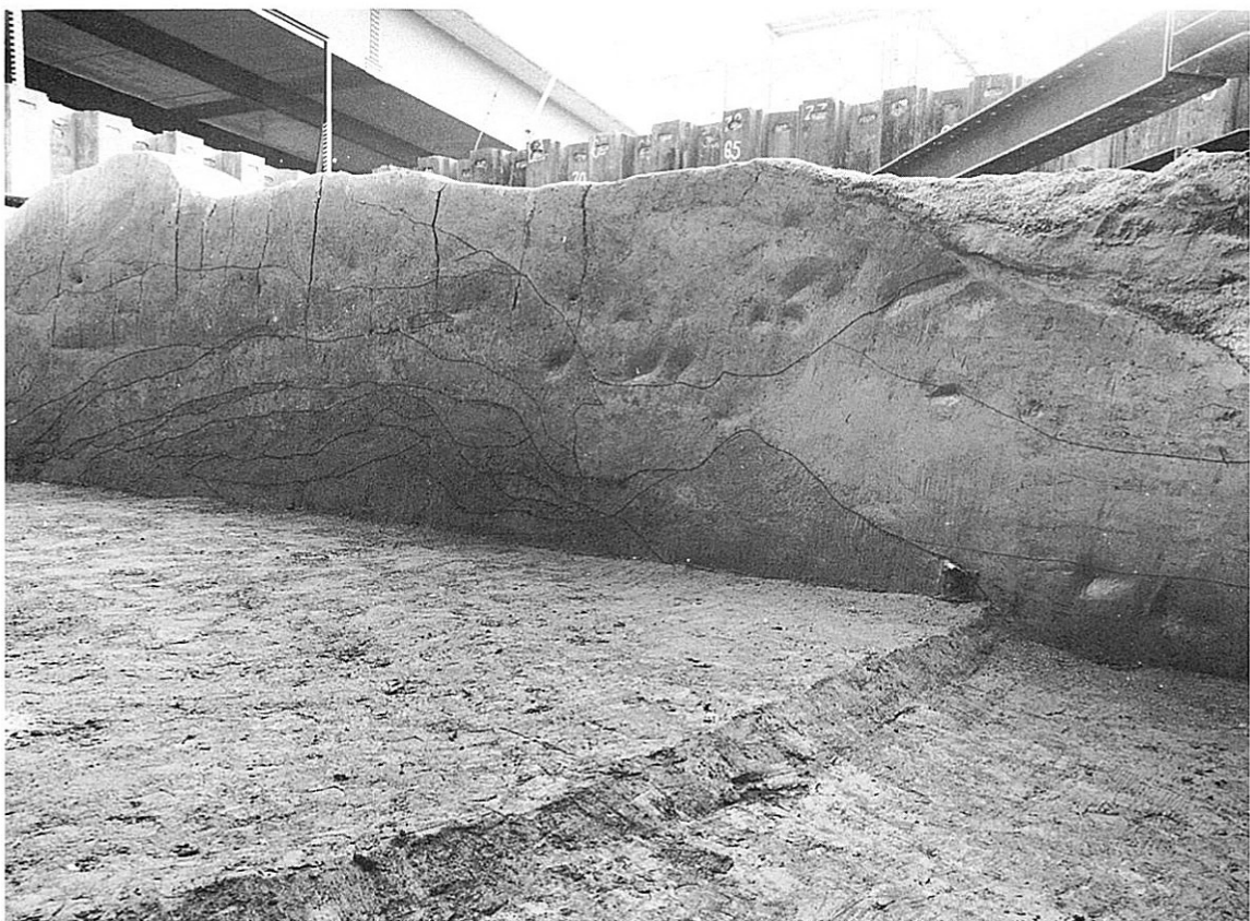
Bトレンチ 右岸堤防土層断面
