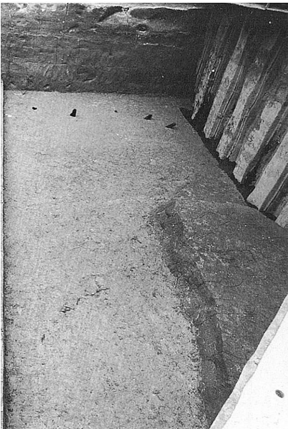
基礎杭列及び古墳時代遺物包含層検出状況
