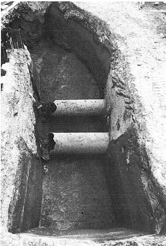
用水路切り替え部（東側）
