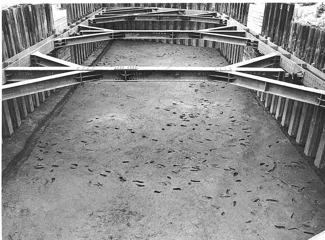
Aトレンチ SA201 (南より)
