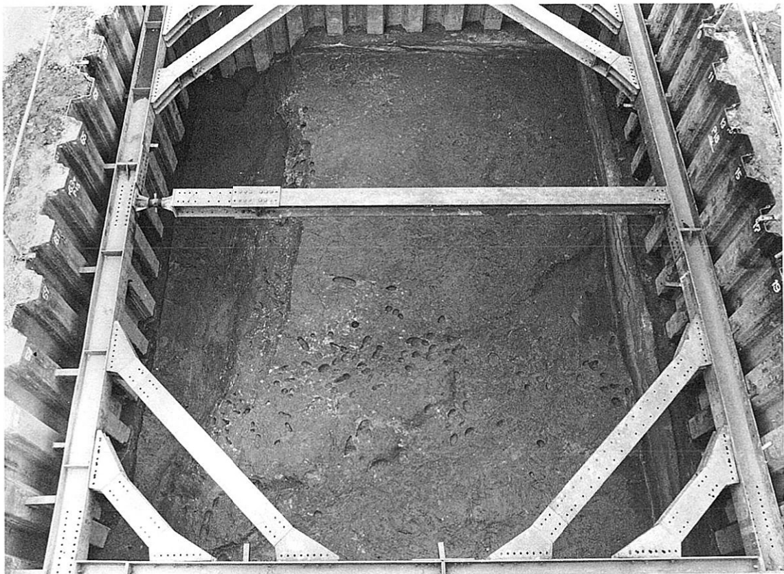
8 Aトレンチ SD213 (南より)
