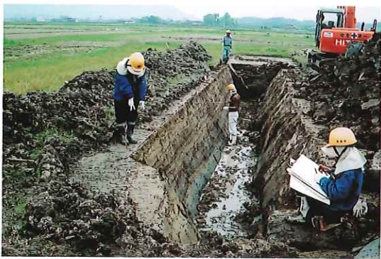
3 確認調査第21トレンチ 作業風景
