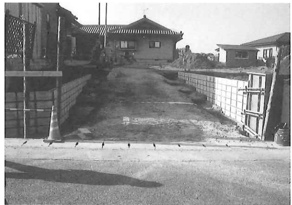
写真59 伊倉古宮原遺跡調査前工事状況
