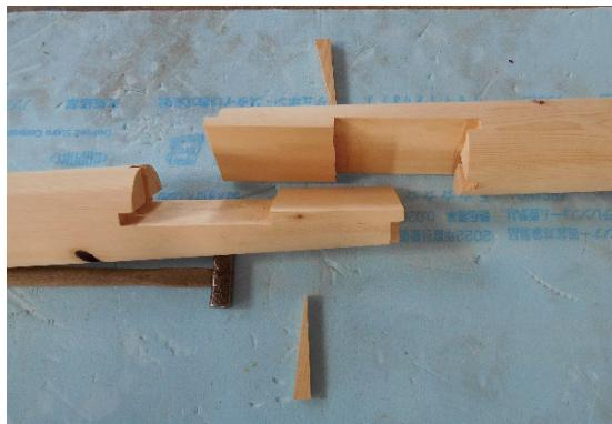
柱根継ぎ模型（金輪継ぎ）
