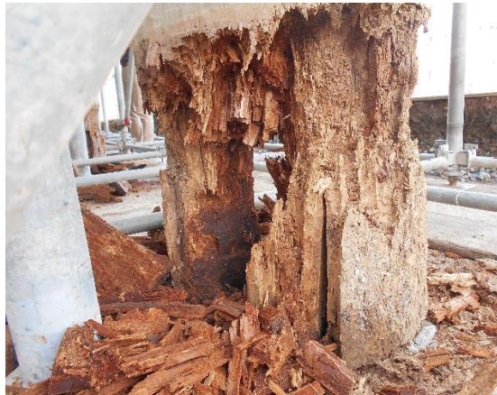
柱材(根元)腐朽状況
