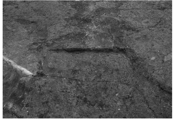
SDC14 断面 BBB (南西から)
